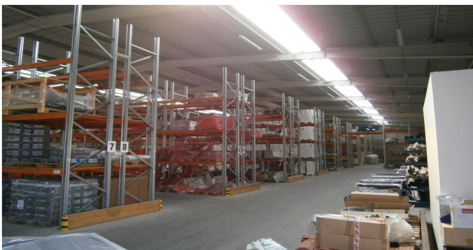
Fotografie č. 3: Skladová hala v Českých Budějovicích – vnitřní plochy 1
