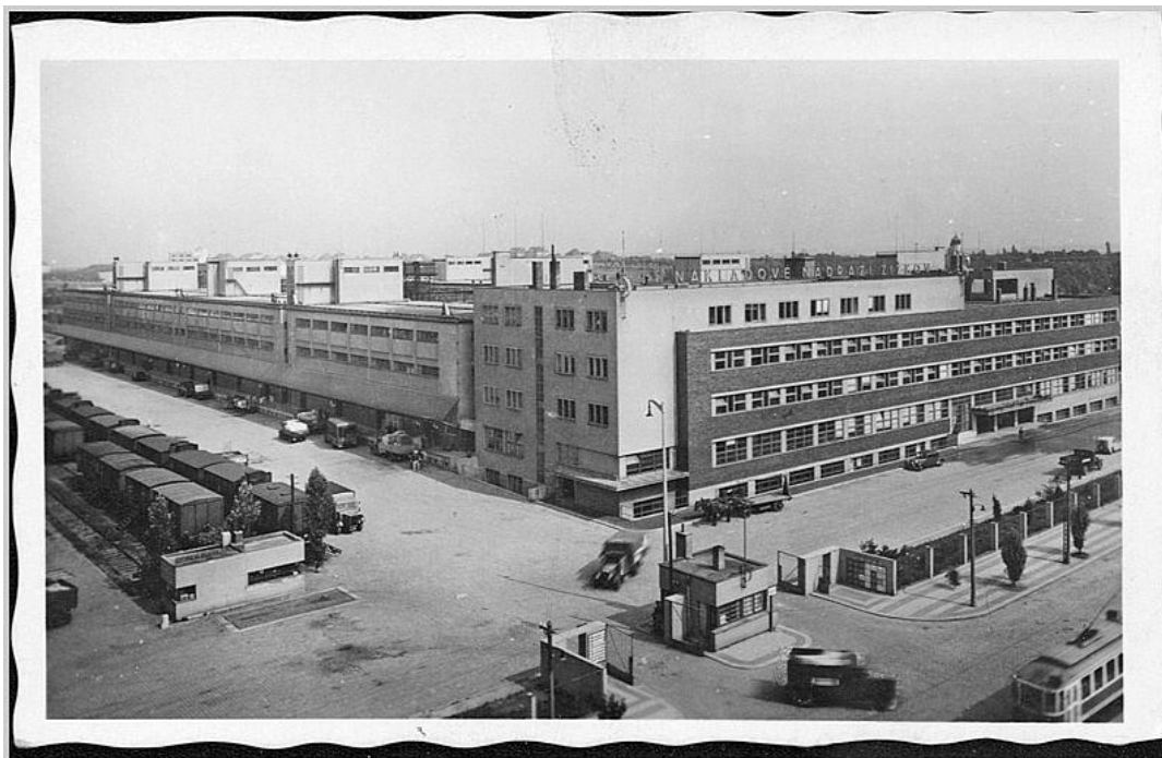
Obr. č. 3 Archivní fotografie nákladového nádraží Zdroj: www.stavbaweb.cz
