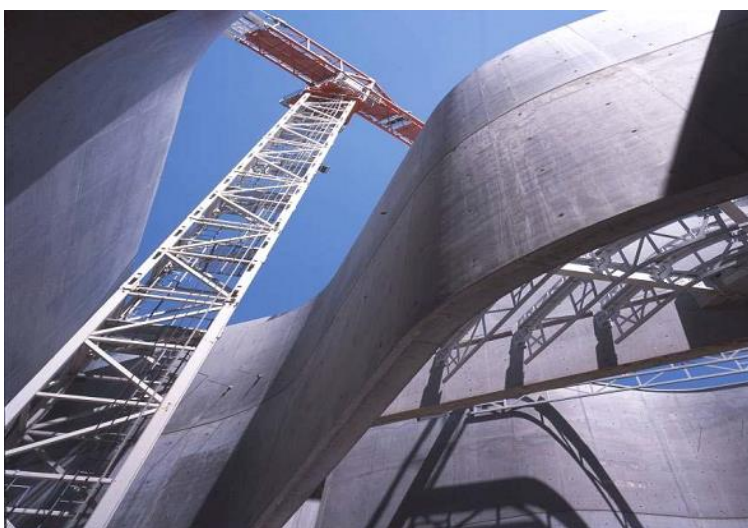
Obrázek 4: Pohled na zakřivené stěny beze spár [15]
