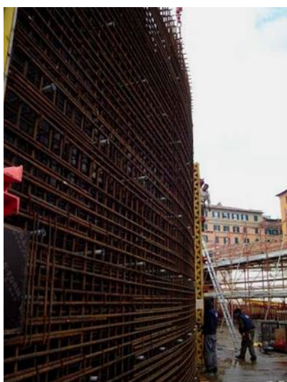
Obrázek 3: Příklad výztuže typické stěny [15]
