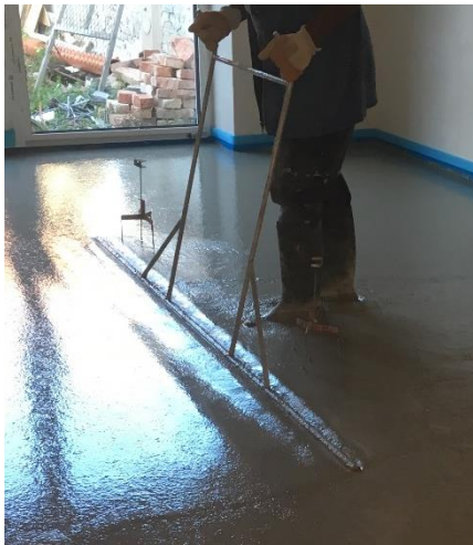
Obrázek 11: Zarovnání potěru vibrační latí.
