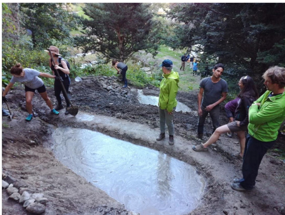
Obr. 8: Budování maličkých zkušebních přírodních retenčních jezírek v rámci semináře permakultury (fotografie autora).
