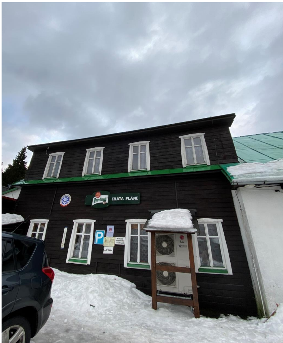
Obrázek č. 27: Restaurace Pláně pod Ještědem Zdroj: vlastní
