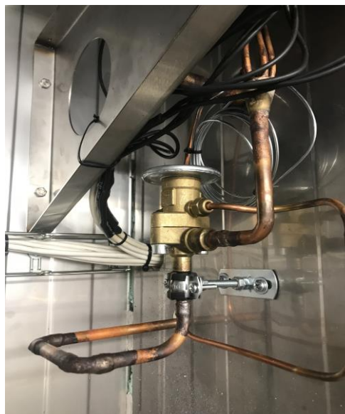
Obrázek 10 Expanzní ventil
