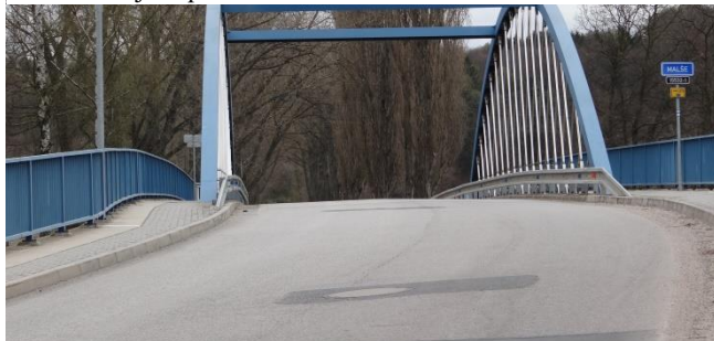
Obr. 54: Přejezd přes most v Roudném
