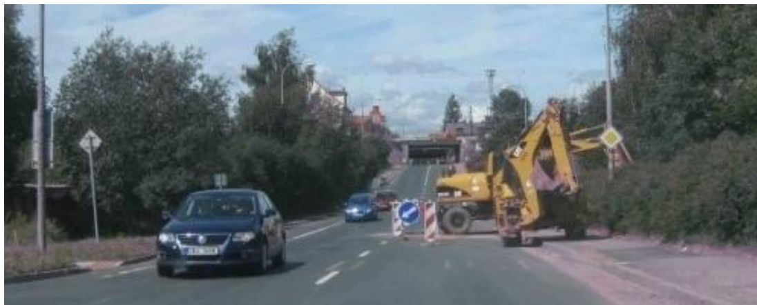
Obr. č. 54 - Překop komunikace po dvou polovinách - zdroj (foto autorka DP, 07/2011)
