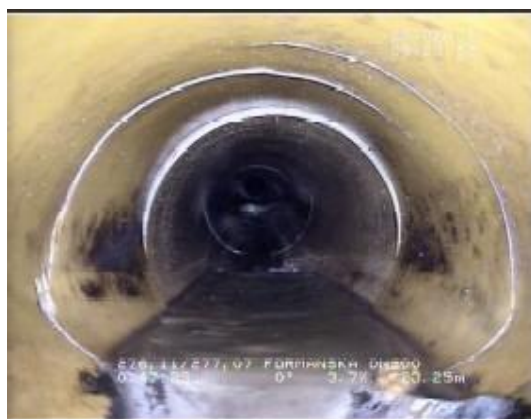
Obr. č. 12 a obr. č. 13 - Příklady ovality kanalizačních trub – zdroj (Dolejš & Bernát, 2011)
