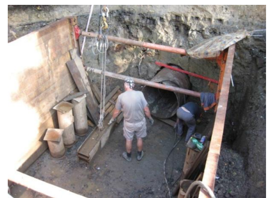
Obr. č. 67, 68, 69, 70, 71, 72, 73, 74 - Protlak pod Pražskou ulicí – zdroj (foto autorka DP 08/2011) – text viz kapitola 5.3.1
