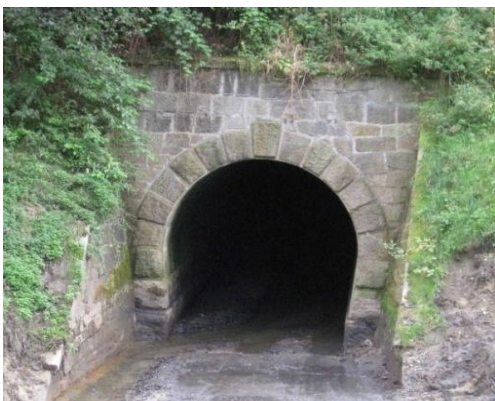
Obr. č. 40, 41 - Železniční mostní objekt po vyčištění od nánosů - zdroj (foto autorka DP, 09/2011)
