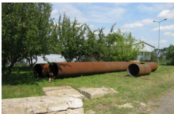
Obr. č. 30 - Ocelová chránička před úpravou - zdroj (foto autorka DP, 08/2011)
