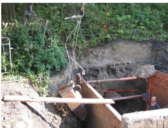
Obr. č. 67, 68, 69, 70, 71, 72, 73, 74 - Protlak pod Pražskou ulicí – zdroj (foto autorka DP 08/2011) – text viz kapitola 5.3.1
