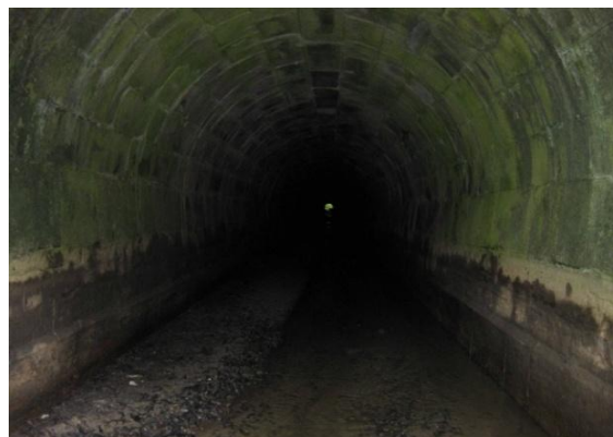
Obr. č. 40, 41 - Železniční mostní objekt po vyčištění od nánosů - zdroj (foto autorka DP, 09/2011)
