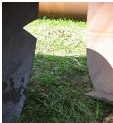
Obr. č. 31 - Ocelová chránička po úpravě pro správné napojení - zdroj (foto autorka DP, 08/2011)
