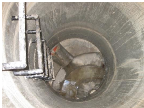
Obr. č. 51 - Pohled do nové kanalizační šachty RŠ3 - zdroj (foto autorka DP, 02/2012)
