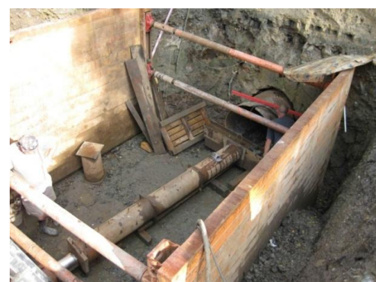
Obr. č. 75, 76, 77, 78, 79, 80, 81, 82 - Protlak pod Pražskou ulicí – zdroj (foto autorka DP 08/2011) – text viz kapitola 5.3.1
