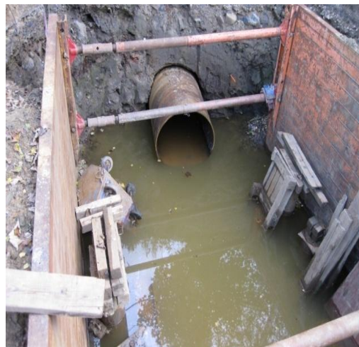
Obr. č. 34 - Startovací jáma - zdroj (foto autorka DP, 08/2011)
