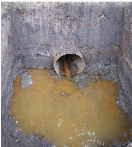
Obr. č. 35 - Koncová jáma - zdroj (foto autorka DP, 08/2011)
