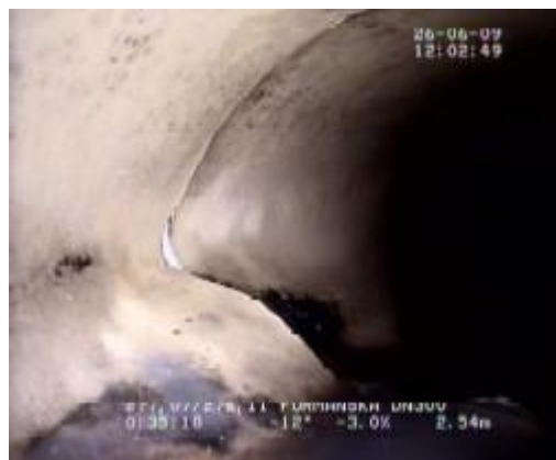
Obr. č. 12 a obr. č. 13 - Příklady ovality kanalizačních trub – zdroj (Dolejš & Bernát, 2011)
