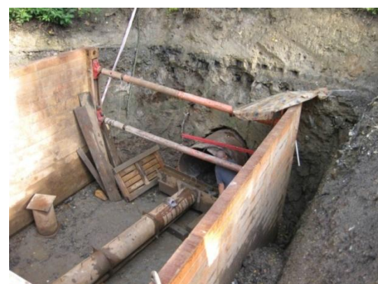
Obr. č. 75, 76, 77, 78, 79, 80, 81, 82 - Protlak pod Pražskou ulicí – zdroj (foto autorka DP 08/2011) – text viz kapitola 5.3.1
