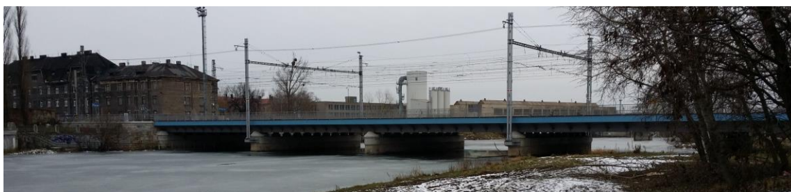
Obrázek 12 - Zrekonstruovaný železniční most; Zdroj: (Tomáš Chromec, 2015)
