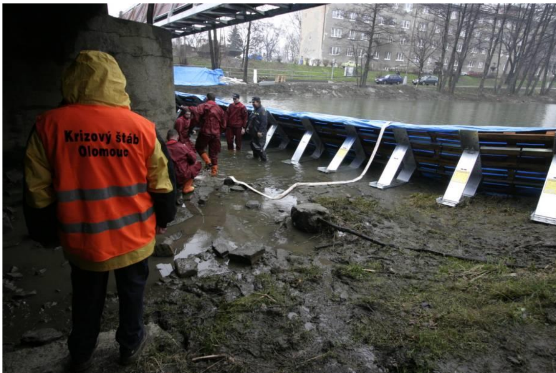
Obrázek 10 - Zkouška mobilní protipovodňové hráže Olomouc; Zdroj: (HZS Olomouc)
