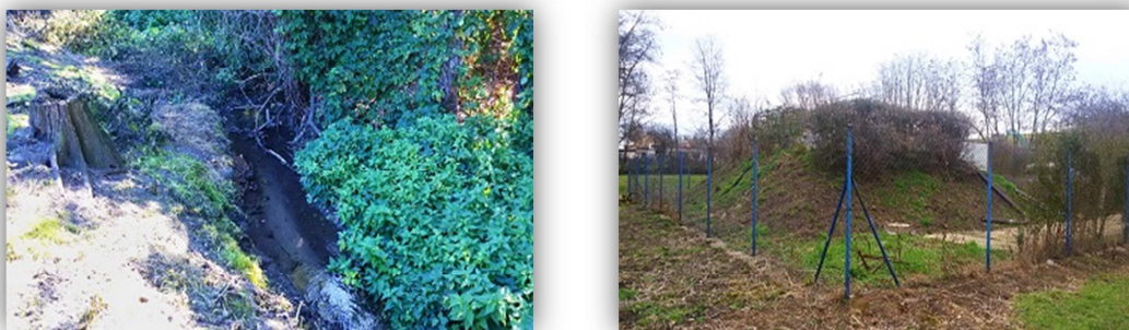
Obr. 8: U čistírny odpadních vod (Foto AUTOR, 2016)
