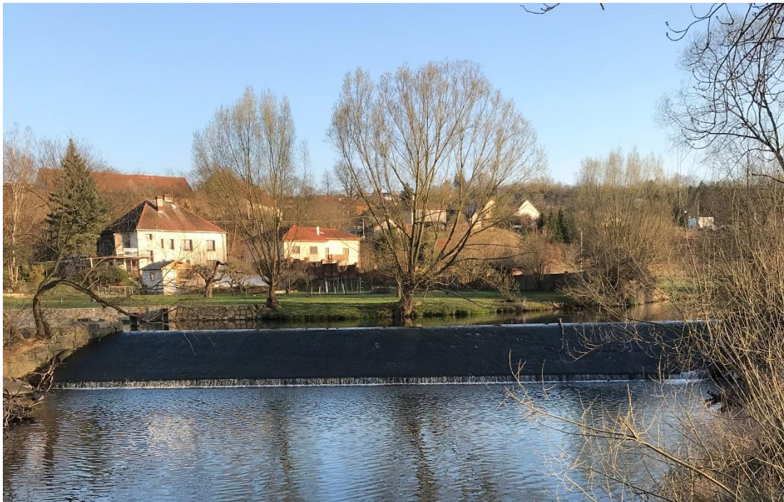
Obrázek 16: Černice – jez (Vlastní foto 2020).
