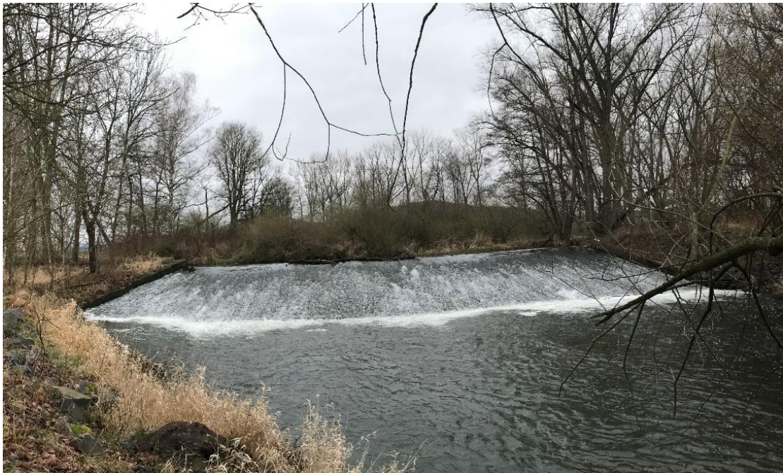
Obrázek 31: Červené poříčí - jez (Vlastní foto 2020).
