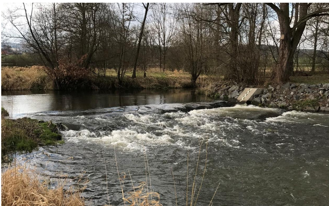
Obrázek 42: Poborovice – balvanitý skluz (Vlastní foto 2020).
