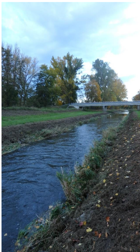
Obrázek 9: Vodní koryto Úhlavy v Malechově-Silniční most (vlastní foto 2020).
