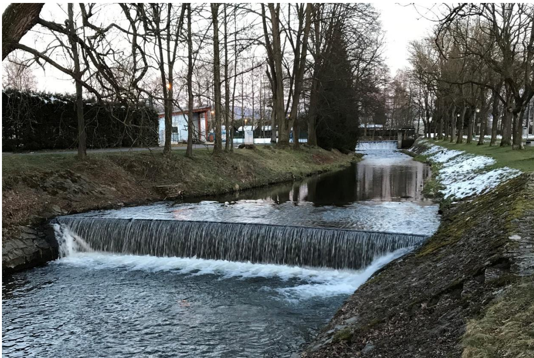
Obrázek 52: Nýrsko – stabilizační stupeň (Vlastní foto 2020).
