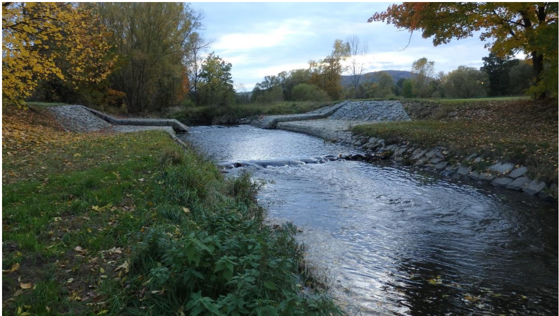
Obrázek 33: Malechov – stabilizační stupeň (Vlastní foto 2019).
