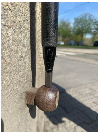
Obr. 28: Tyč s hranolem na nivelační značce
