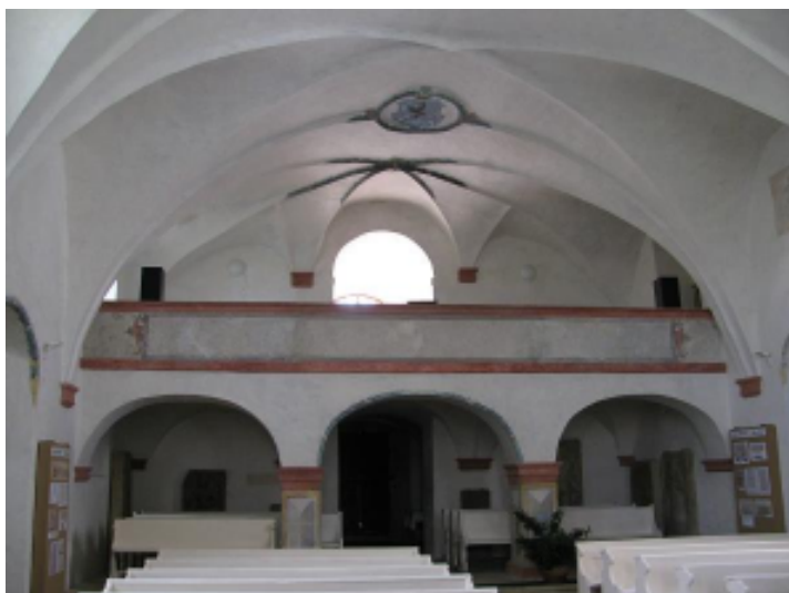
Obr.47–MladáBoleslav,h řbitovníkostelsv.Havla,pohleddointeriéru,sm ěr východ-západ.Foto:autorka
