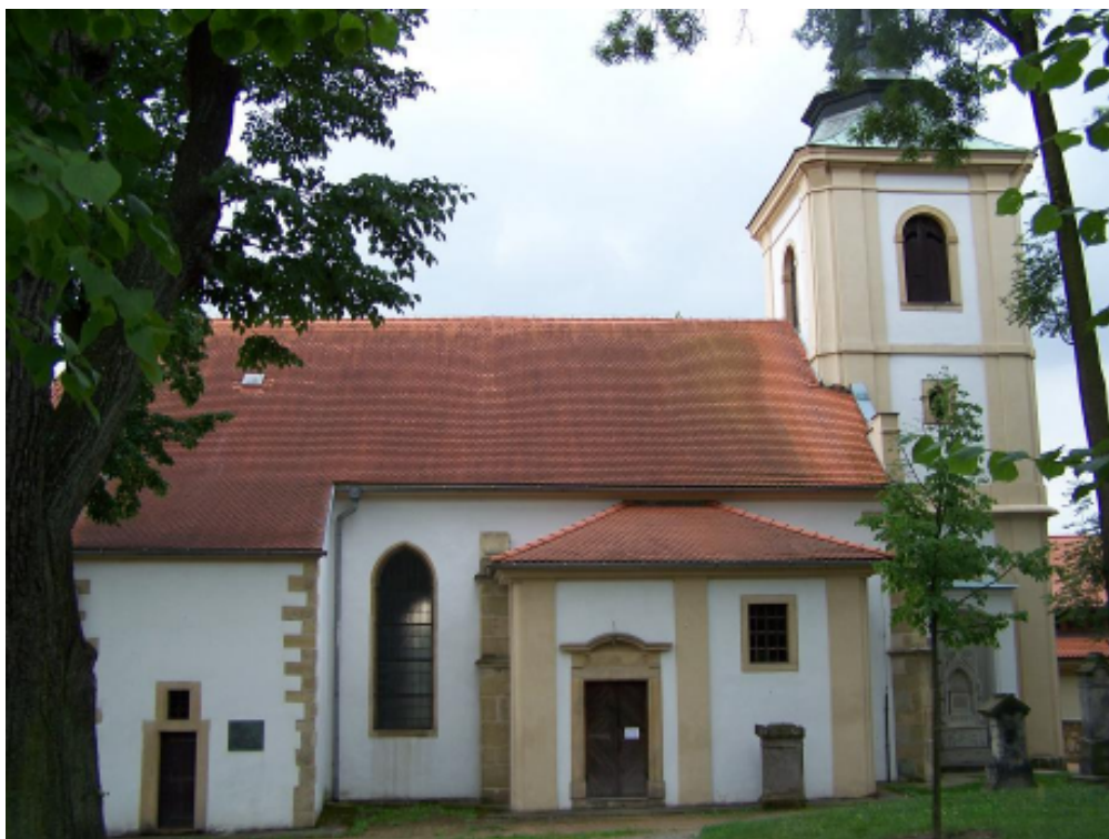
Obr.45-MladáBoleslav,h řbitovníkostelsv.Havla,celkovýpohlednajižní průčelí.Foto:autorka
