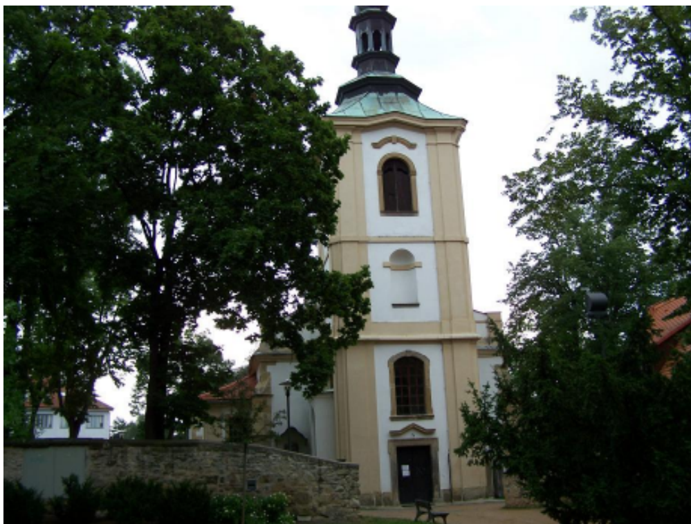
Obr.43-MladáBoleslav,h řbitovníkostelsv.Havla,celkovýpohlednazápadní průčelí.Foto:autorka
