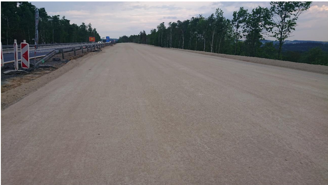
Obrázek 24: Nově zhotovená recyklovaná vrstva (12)
