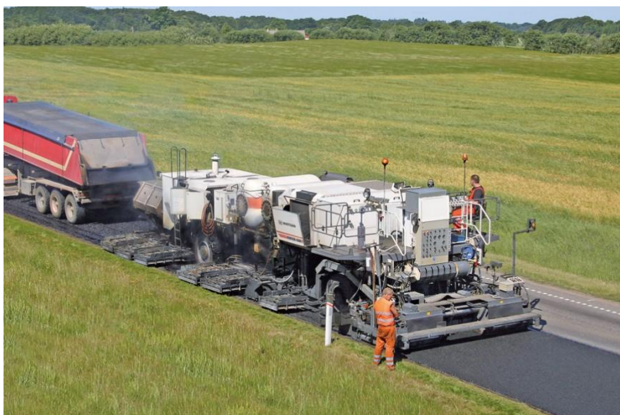
Obrázek 8: Recyklační souprava za horka WIRTGEN (8)
