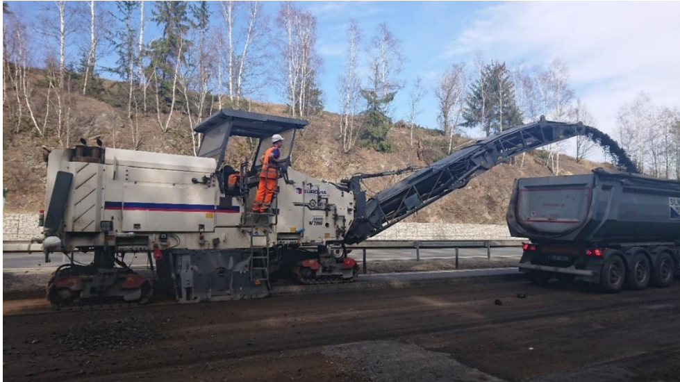
Obrázek 14: Frézování asfaltových vrstev vozovky (12)
