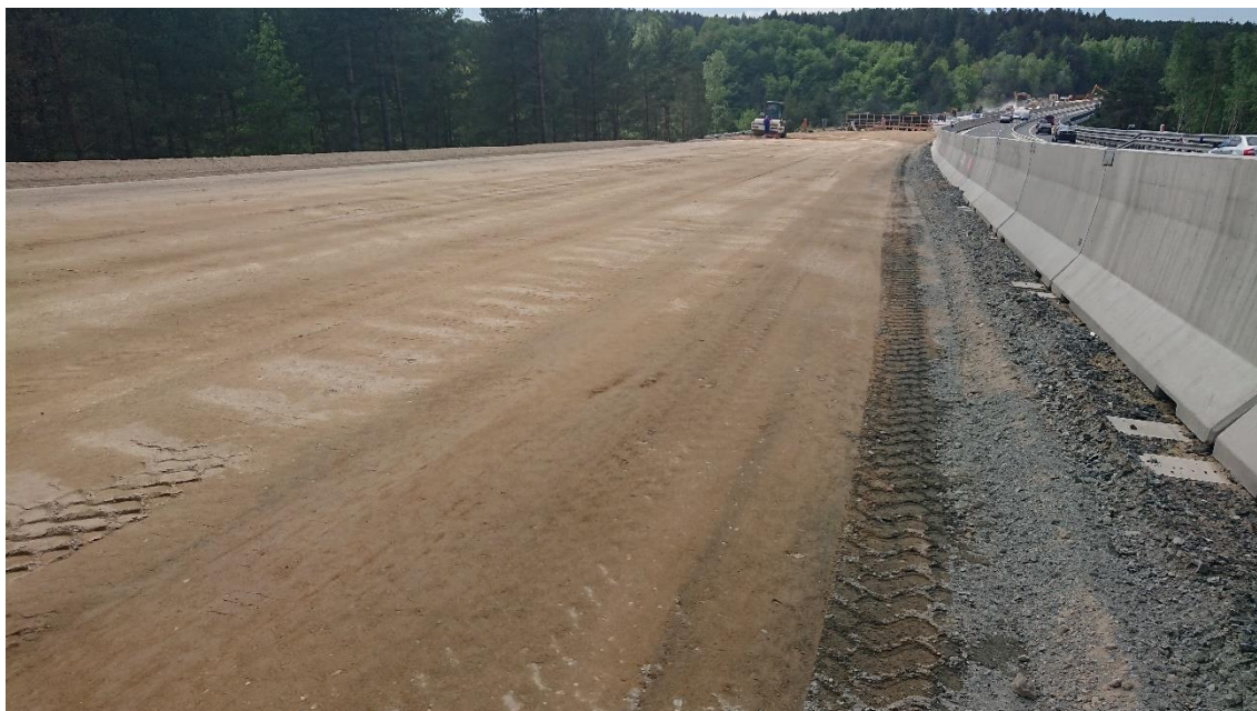
Obrázek 23: Třetí úsek – hutnění válcem (12)
