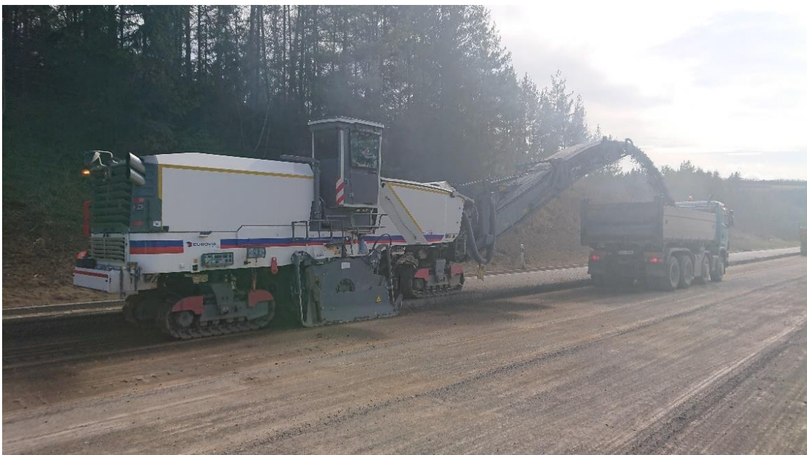
Obrázek 13: Frézování asfaltových vrstev vozovky (12)
