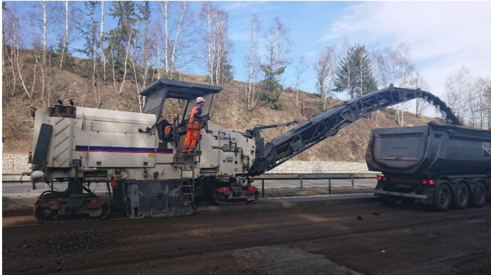
Obrázek 14: Frézování asfaltových vrstev vozovky (12)
