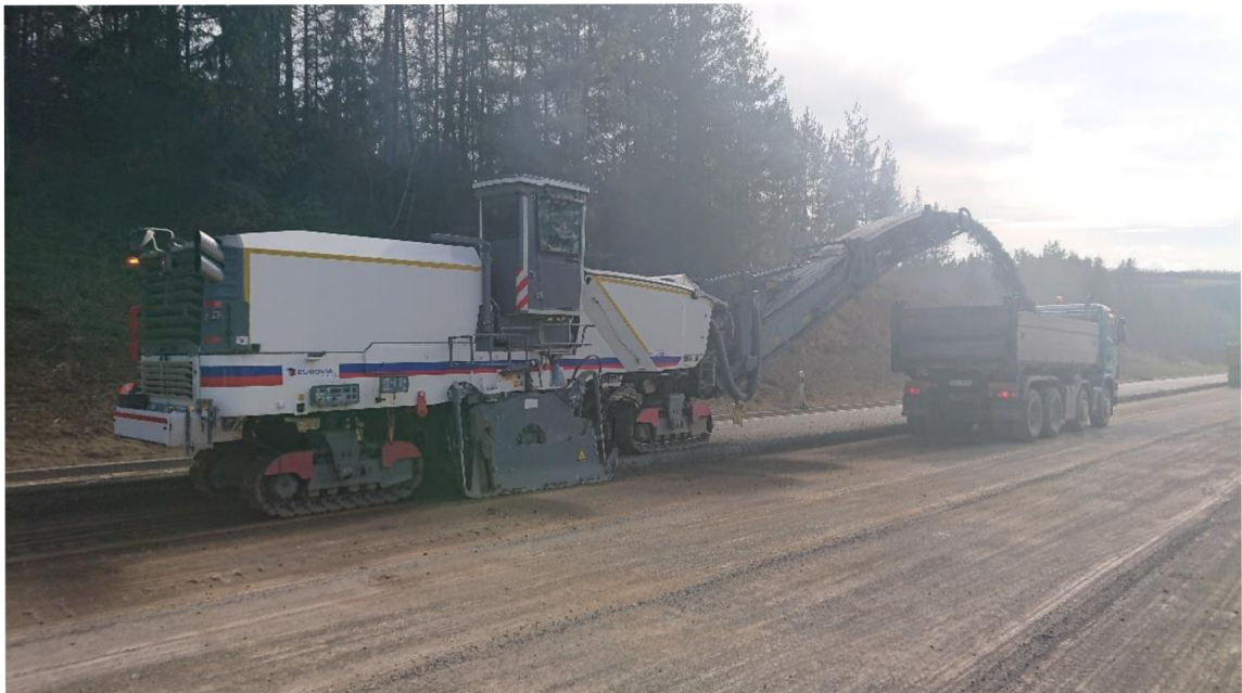
Obrázek 13: Frézování asfaltových vrstev vozovky (12)
