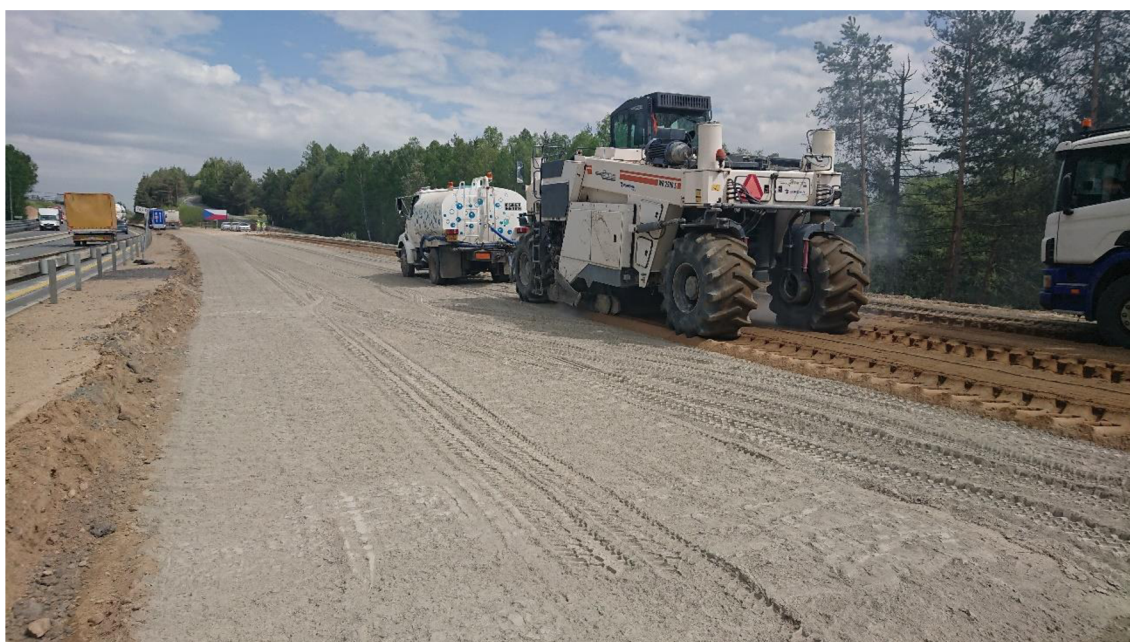
Obrázek 21: „Vláček“ - kropicí vůz s recyklační frézou na prvním úseku (12)
