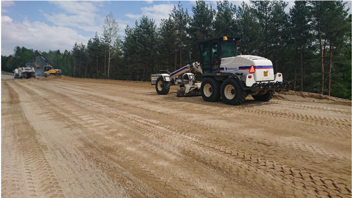
Obrázek 22: Druhý úsek - rovnání grejdrem (12)
