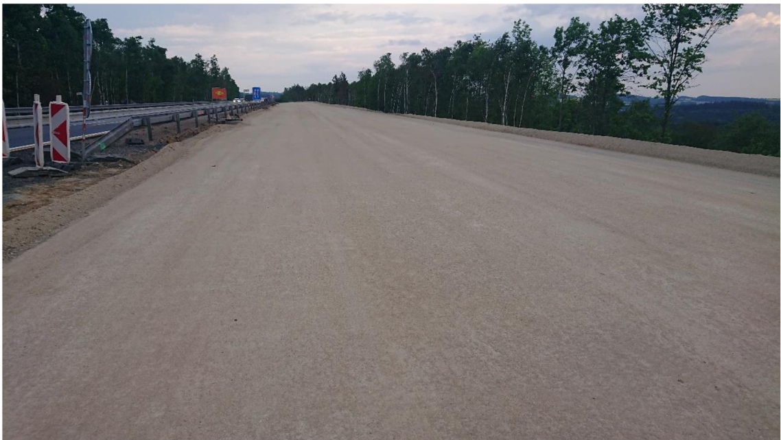
Obrázek 24: Nově zhotovená recyklovaná vrstva (12)
