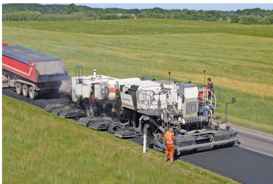
Obrázek 8: Recyklační souprava za horka WIRTGEN (8)
