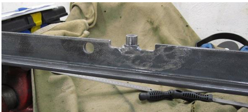
Obrázek 50 – výložník – boční vedení – detail
