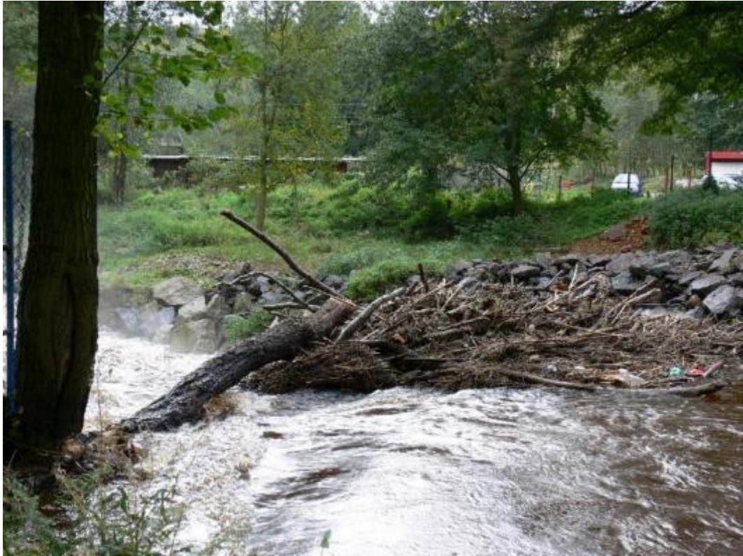
Obr. P – 7: Zanesení jezu, Foto: Ing. Ján Gazdačko
