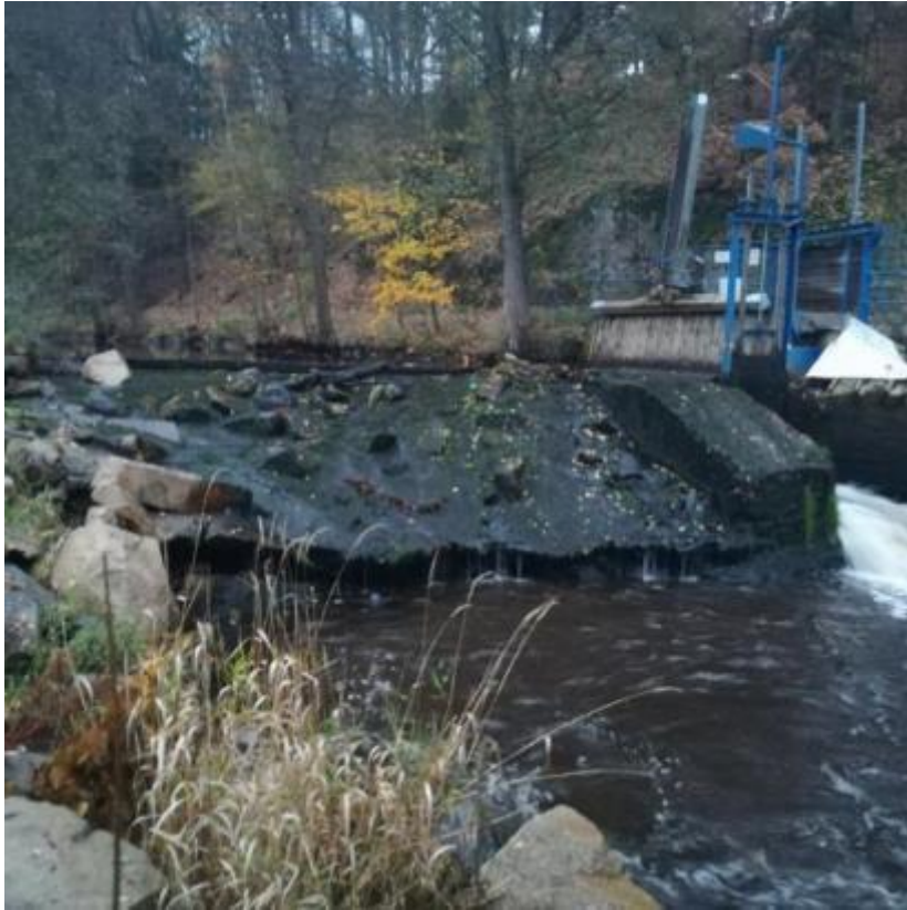
Obr. P – 3: Pohled na jez za vyhrazení stavidel
