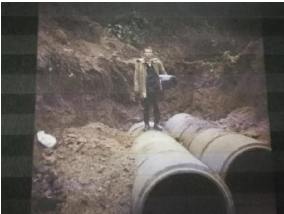
Obr. P – 12: Dokumentace výstavby MVE ve Staré Roli, Foto: Ing. Ján Gazdačko
