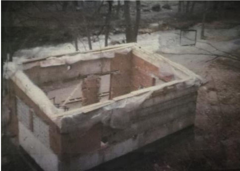
Obr. P – 11: Dokumentace výstavby MVE ve Staré Roli, Foto: Ing. Ján Gazdačko
