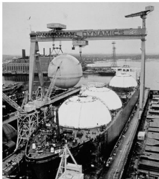
Obr.č.21: Probíhající instalace nádrží na trup lodi [1]
