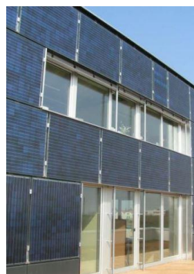
Obr. 2-8 Studená integrovaná fasáda s bodovým uchycením [30]
