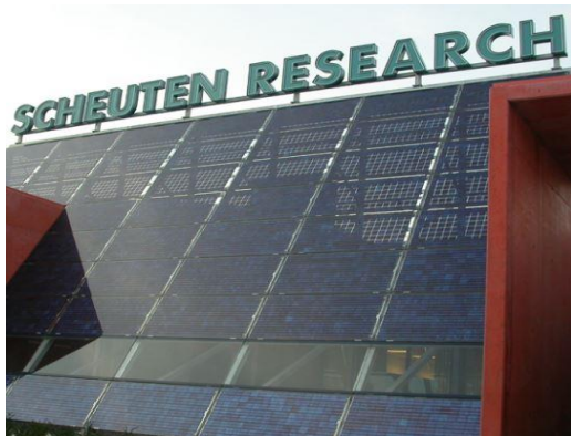
Obr. 2-5 Teplá integrovaná fasáda propouštějící světlo [27]
