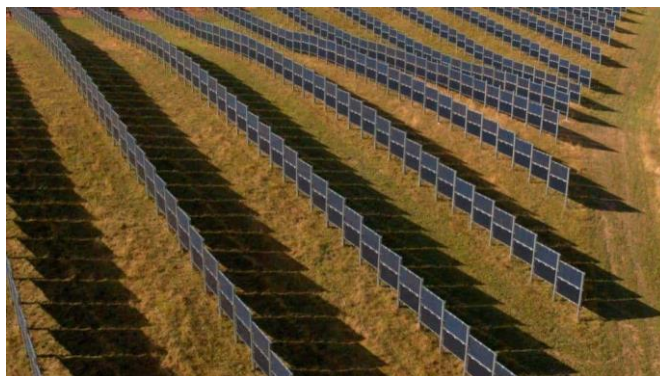
Obr. 2-24 Pole se systémem od společnosti Next2sun [12]
