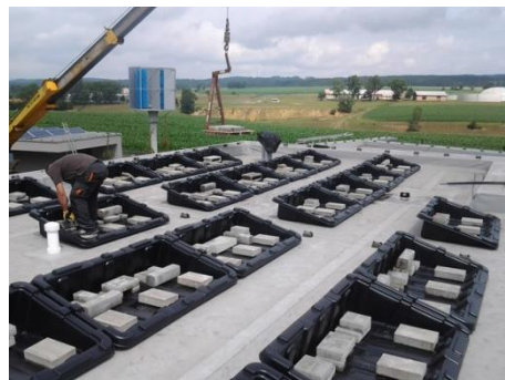
Obr. 2-18 Plastové vany zatíženy betonovými deskami [18]
