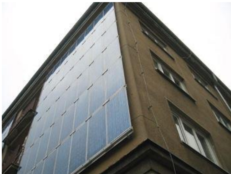
Obr. 2-4 Aditivní fasádní instalace [26]
