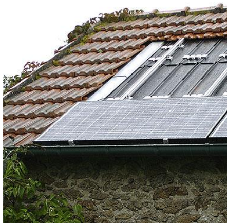
Obr. 2-21 Integrovaná fotovoltaická elektrárna s přidanou spodní izolací [15]
