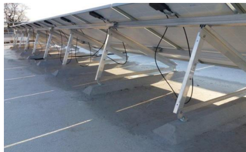
Obr. 2-20 Nosná konstrukce ukotvena k nosné konstrukci [16]
