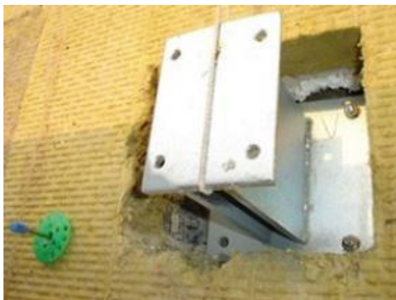
Obr. 2-3 Kotva uchycená k nosné stěně [32]
