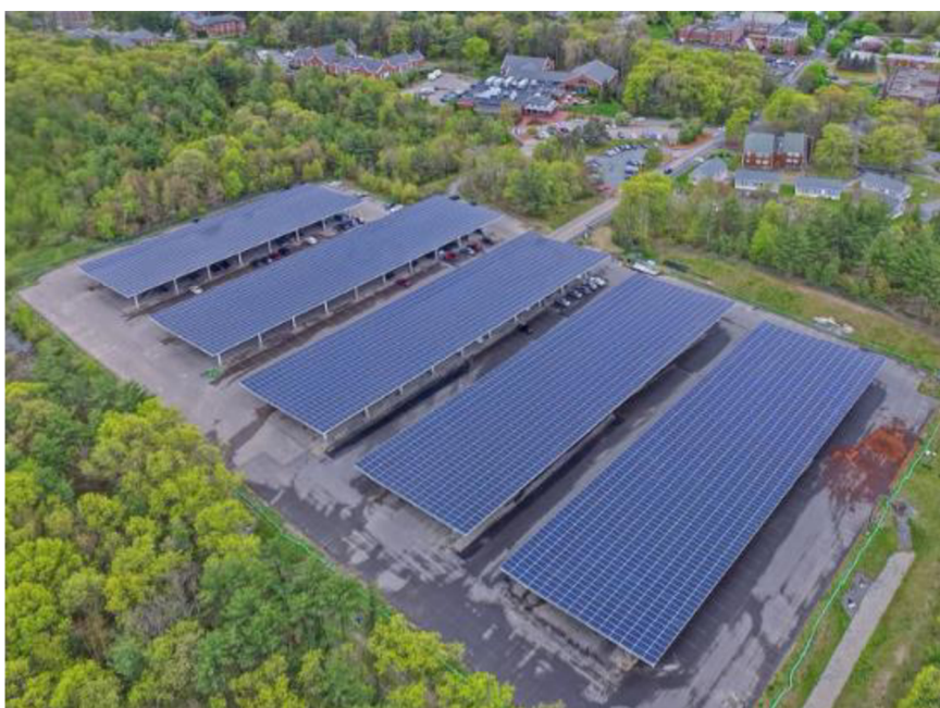
Obr. 2-28 Fotovoltaické parkoviště vysoké školy Stonehill College [52]
