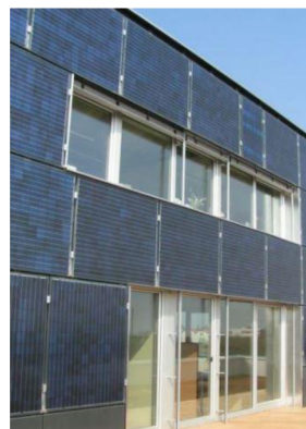
Obr. 2-8 Studená integrovaná fasáda s bodovým uchycením [30]
