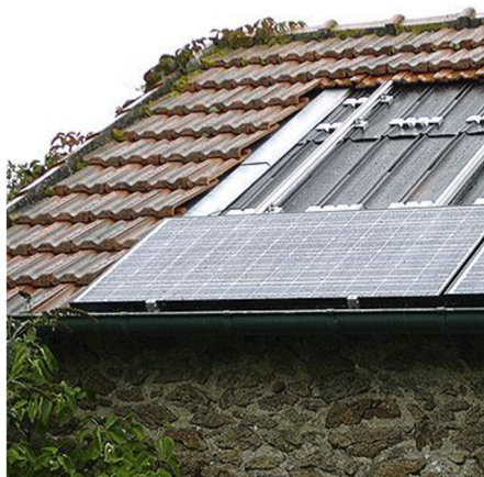
Obr. 2-21 Integrovaná fotovoltaická elektrárna s přidanou spodní izolací [15]
