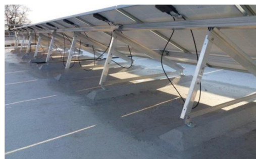
Obr. 2-20 Nosná konstrukce ukotvena k nosné konstrukci [16]
