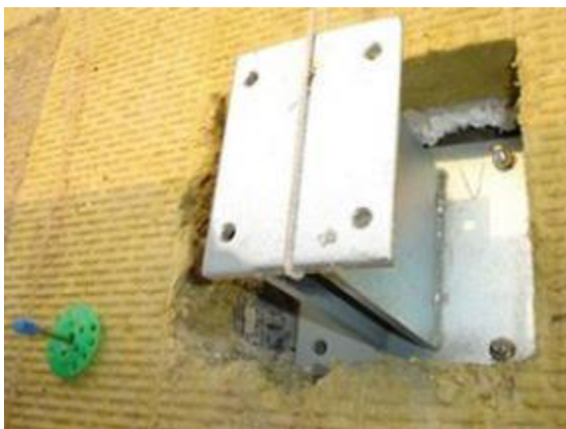
Obr. 2-3 Kotva uchycená k nosné stěně [32]
