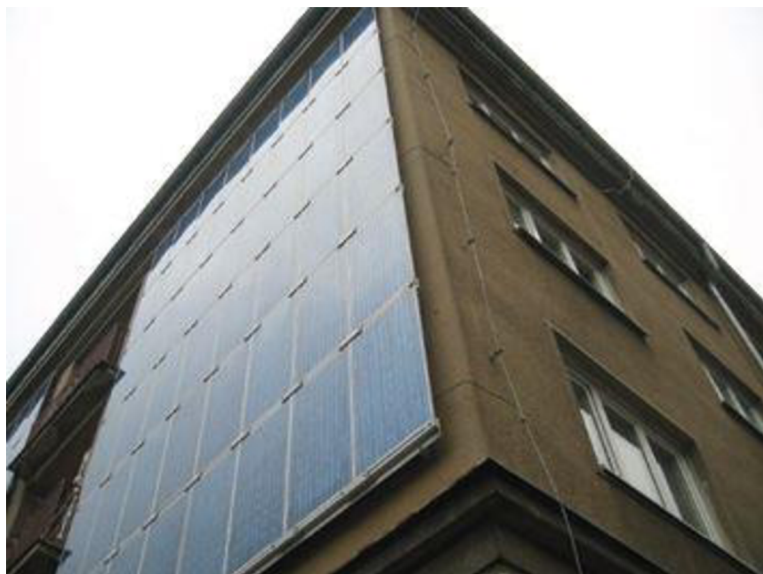
Obr. 2-4 Aditivní fasádní instalace [26]
