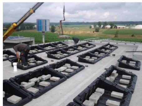
Obr. 2-18 Plastové vany zatíženy betonovými deskami [18]
