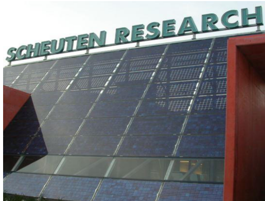
Obr. 2-5 Teplá integrovaná fasáda propouštějící světlo [27]
