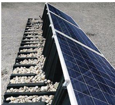
Obr. 2-17 Plastové vany zatíženy pískem [19]
