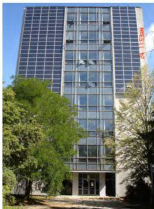
Obr. 8-5 Fotovoltaická instalace na budově Fakulty stavební ČVUT v Praze [42]
