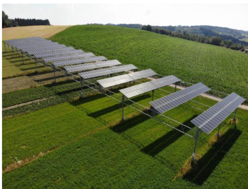
Obr. 2-26 Pole se systémem od společnosti Fraunhofer ISE [10]
