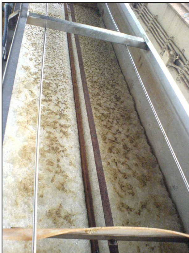
Obrázek 21. Kal na hladině poloprovozního modelu DAF při provozu s nadávkovanou vodou z úpravny vody Jirkov (1. etapa experimentů) při dávce koagulantu mimo optimum [P. Dobiáš]
