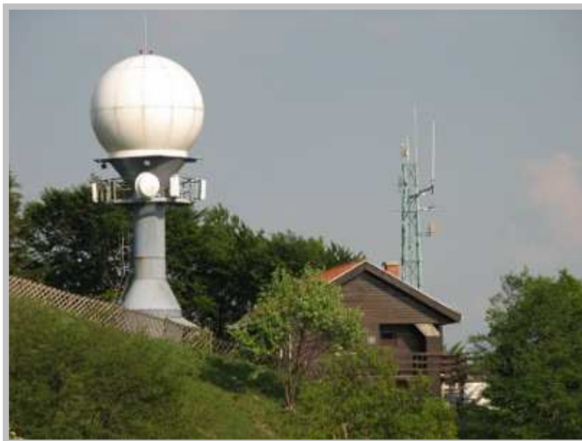
Obr. 1 Meteorologický radar a meteorologická stanice, Slovinsko [15]
