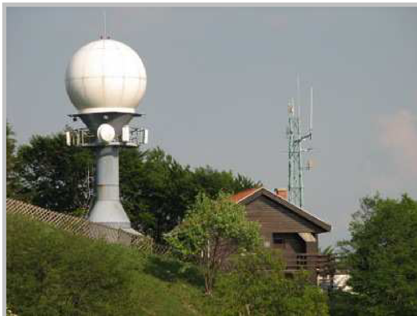
Obr. 1 Meteorologický radar a meteorologická stanice, Slovinsko [15]
