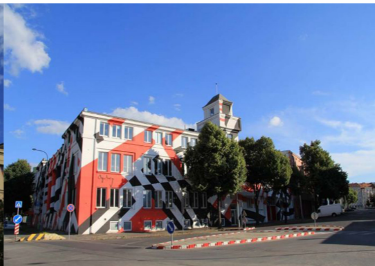
SÍDLO OGILVY - DŘÍVE PEKÁRNA A SODOVÁRNA
