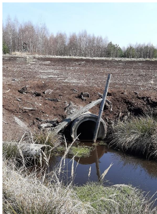
Obrázek 29 Odkryté drenážní potrubí
