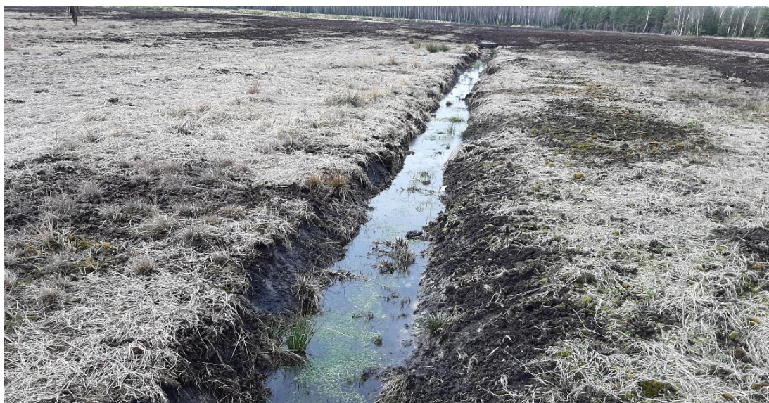
Obrázek 25 Plocha B – detail odvodňovacího kanálu
