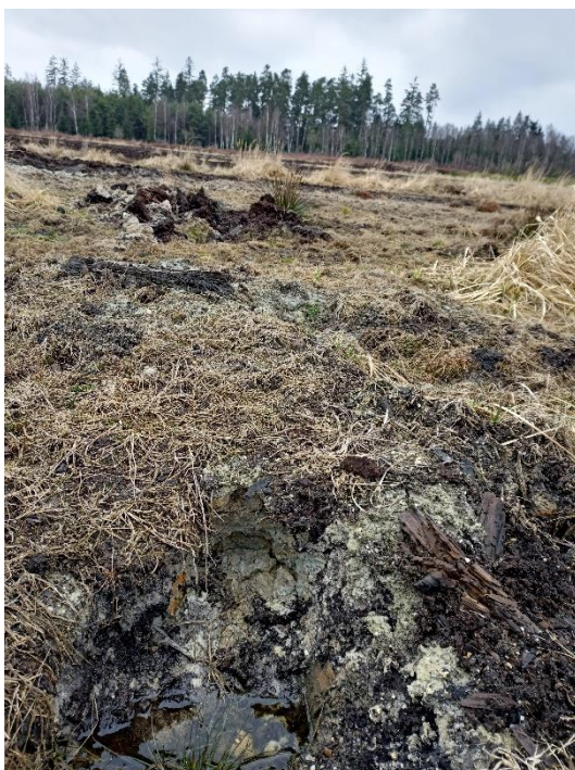
Obrázek 30 Odtěžení rašeliny na jílovou vrstvu
