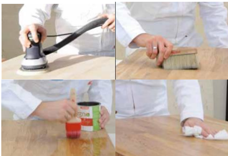
Obr. 34 Nanesení bezbarvého oleje Adler (Adler, 2016)
