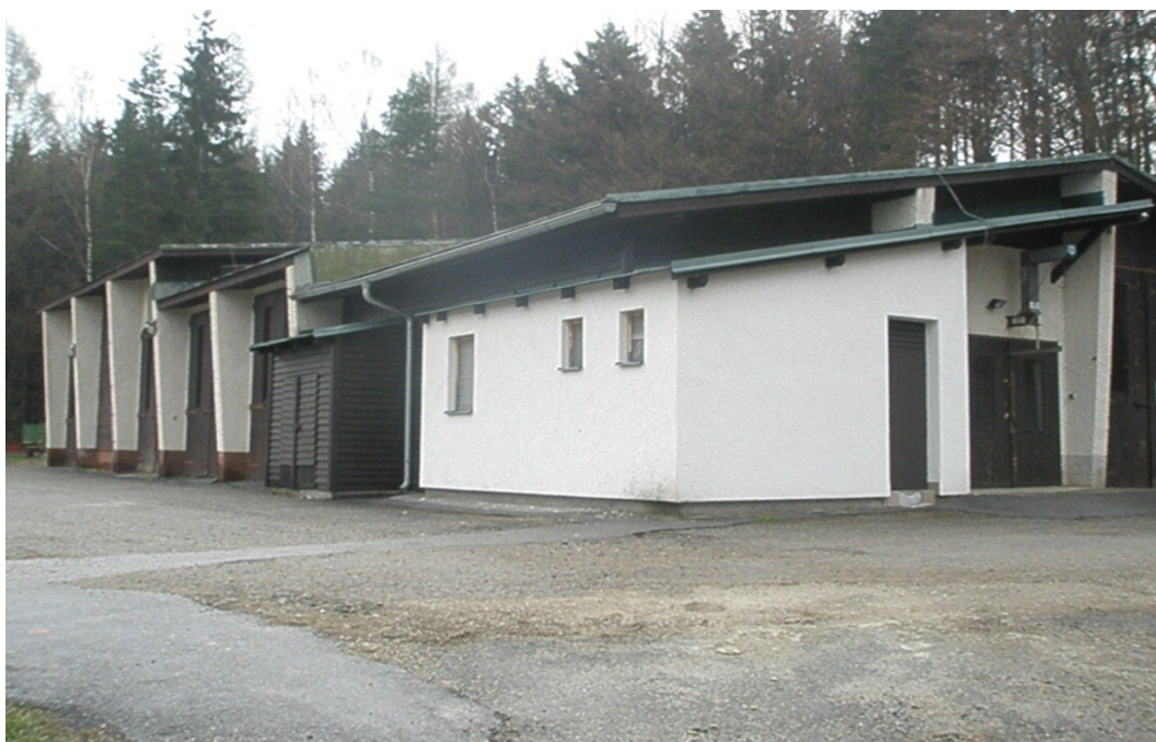
7.6.7 Obrázek č. 8: Pohled na mísírnu, jejíž část tvoří chladírna
