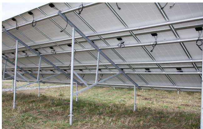
Obrázek 6 Nosná konstrukce panelů
