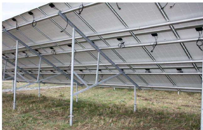
Obrázek 6 Nosná konstrukce panelů
