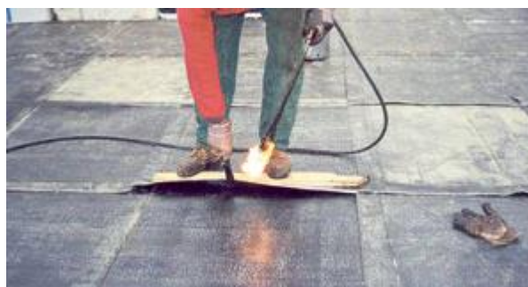
Obrázok 9.6-1: natavovanie spojov, zdroj [38]
