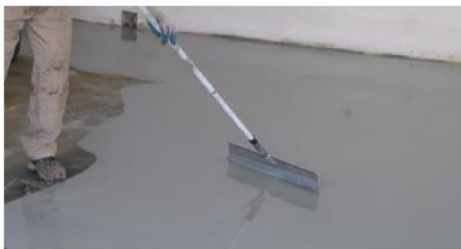
Obrázok 9.10-8: rozotieranie epoxidovej stierky, zdroj [44]
