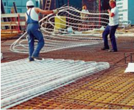
Obrázok 12.2-4: ukladanie modulov do debnenia, zdroj [50]
