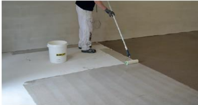
Obrázok 9.10-6: nanášanie penetrácie pomocou valčeka, zdroj [44]
