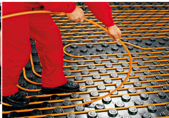
Obrázok 9.8-2:ukladanie trubiek podlahového vykurovania, zdroj [41]
