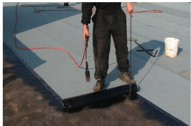
Obrázok 9.6-2: natavovanie asfaltových pásov, zdroj [37]
