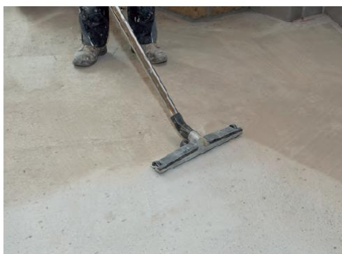
Obrázok 9.10-4: vysávanie poteru, zdroj [44]
