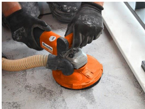
Obrázok 9.10-3: ručné frézovanie poteru, zdroj [45]
