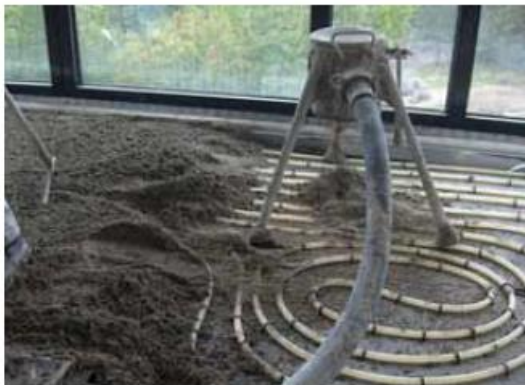
Obrázok 9.9-5: ukladanie zmesi, zdroj [42]
