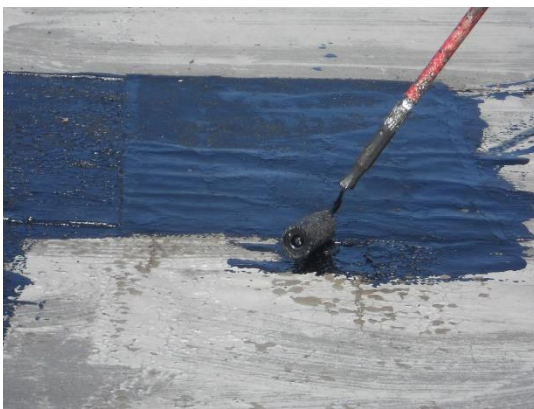
Obrázok 9.6-1: nanášanie penetračného náteru, zdroj [36]
