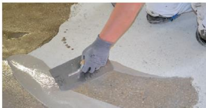
Obrázok 9.10-7: nanášanie epoxidovej malty pomocou hladítka, zdroj [44]
