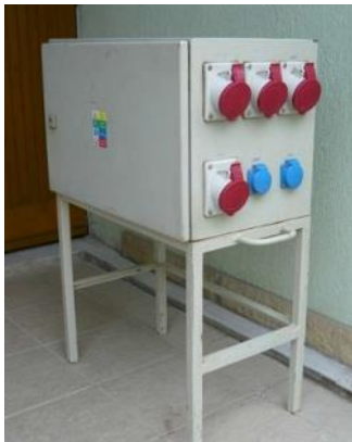
Obrázok 5.7-12: staveniskový rozvádzač, zdroj [21]
