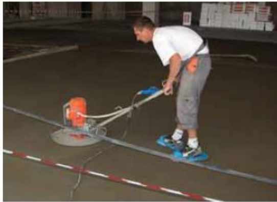
Obrázok 9.9-7: strojné hadenie poteru, zdroj [42]
