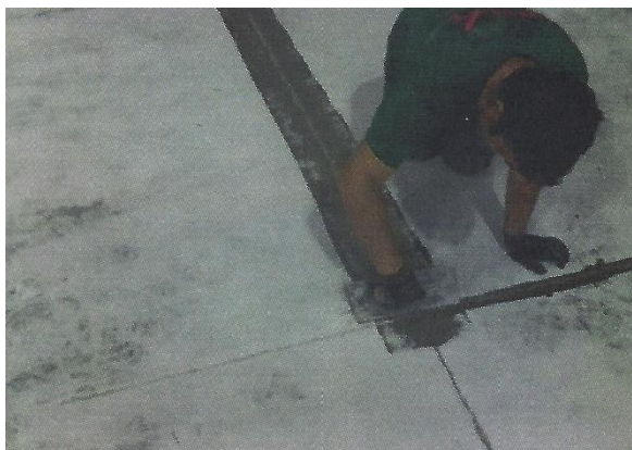
Obrázok 9.10-5: rezanie kotviacich drážok, zdroj [46]
