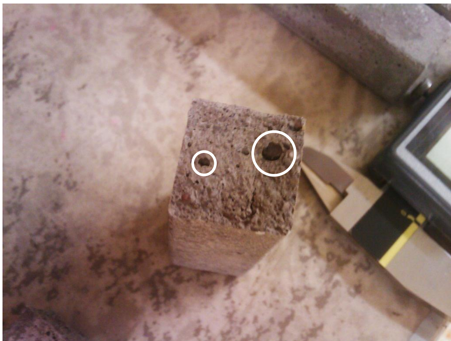
Obrázek 24: Bubliny a trhliny (průměr cca. 2,6 a 1,4 mm) ve vzorku geopolymerního betonu, po zkoušce v tahu za ohybu
