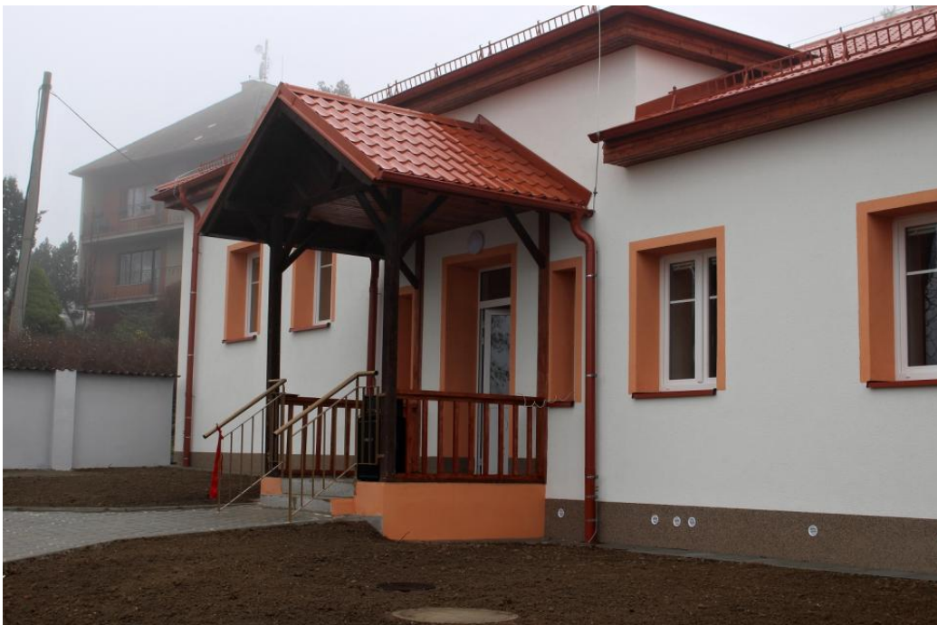
Obrázek č. 3 – Nová budova Domova pro osoby se zdravotním postižením v Chotěšově
