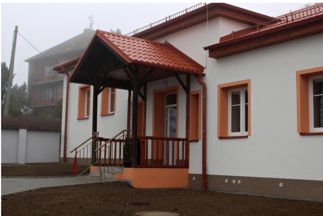
Obrázek č. 3 – Nová budova Domova pro osoby se zdravotním postižením v Chotěšově
