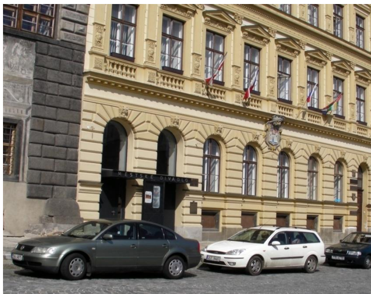
Obrázek 3-1 Budova Městského divadla v Prachaticích
