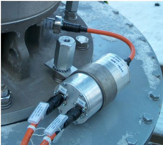
Obr. 5-4 Snímací průchodkový prvek 400 kV [5]
