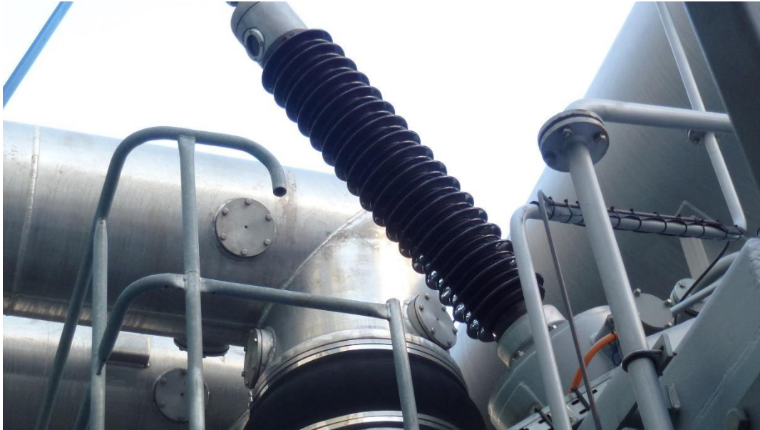
Obr. 3-2 Průchodka 123 kV pro vyvedení uzlu vinutí VVN [5]
