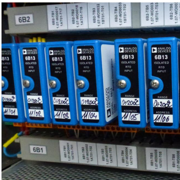
Obr. 5-10 Instalace 6B13 modulů [5]
