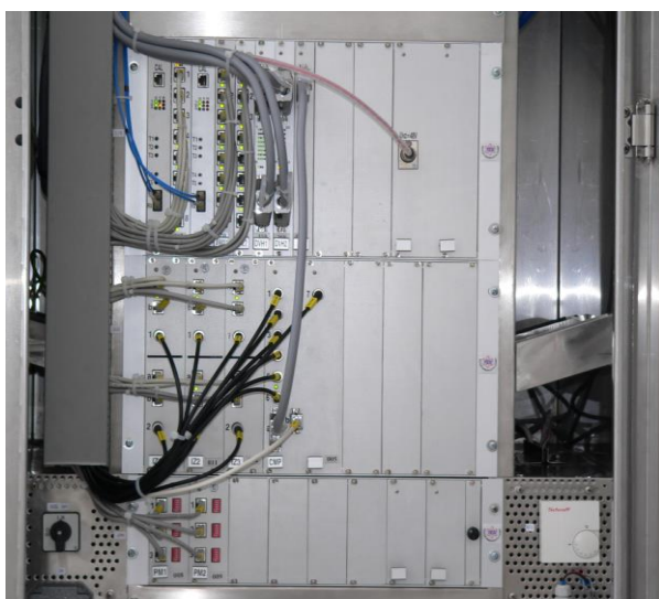
Obr. 4-6 Měřicí skříň MT01 (měřicí ústředna, jednotka úpravy signálů, nosič proudových modulů) [5]
