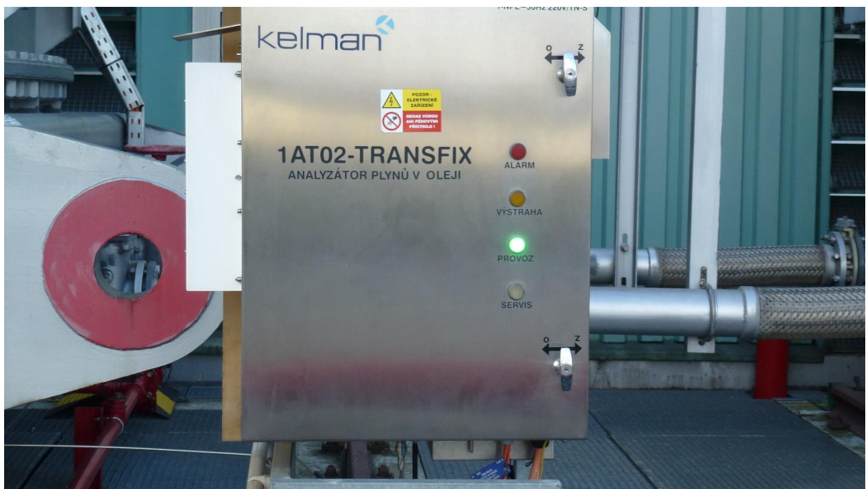
Obr. 3-4 Skříň analyzátoru plynů TRANSFIX [5]
