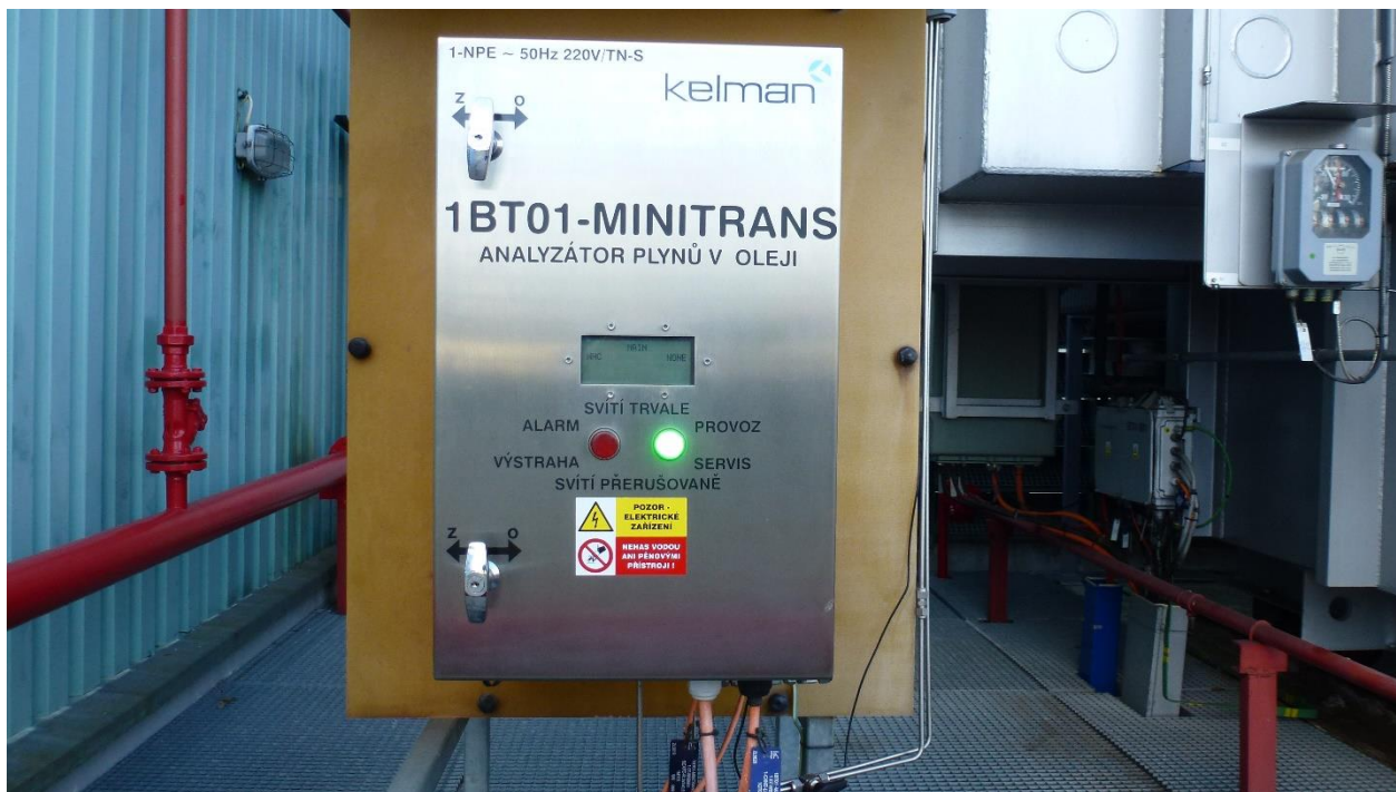
Obr. 3-6 Skříň analyzátoru plynů MINITRANS [5]
