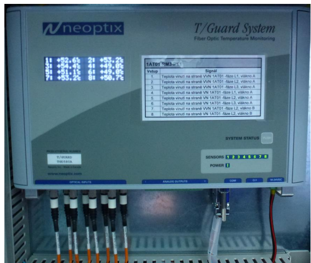
Obr. 5-8 Monitor teplot vinutí TGuard-TM [5]
