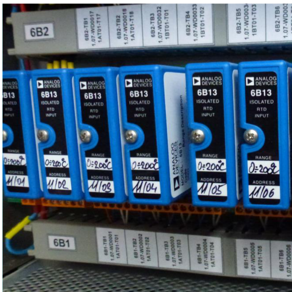
Obr. 5-10 Instalace 6B13 modulů [5]
