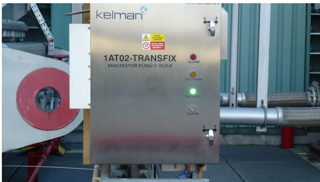
Obr. 3-4 Skříň analyzátoru plynů TRANSFIX [5]
