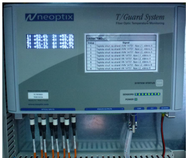
Obr. 5-8 Monitor teplot vinutí TGuard-TM [5]
