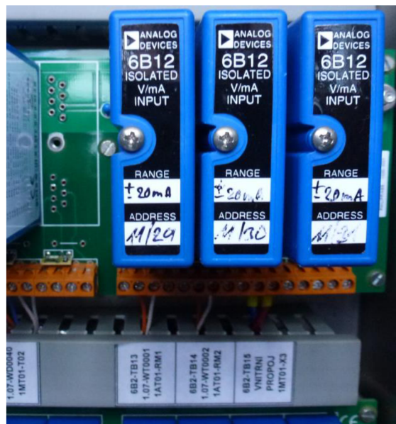
Obr. 5-11 Instalace 6B12 modulů [5]
