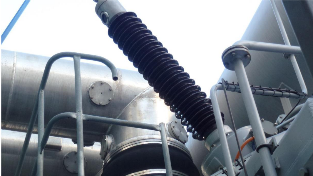
Obr. 3-2 Průchodka 123 kV pro vyvedení uzlu vinutí VVN [5]
