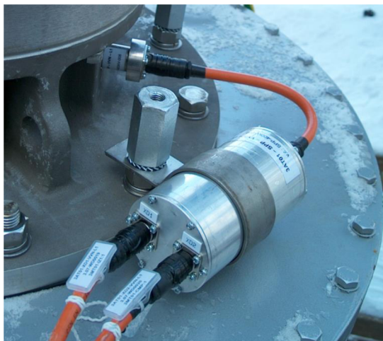
Obr. 5-4 Snímací průchodkový prvek 400 kV [5]
