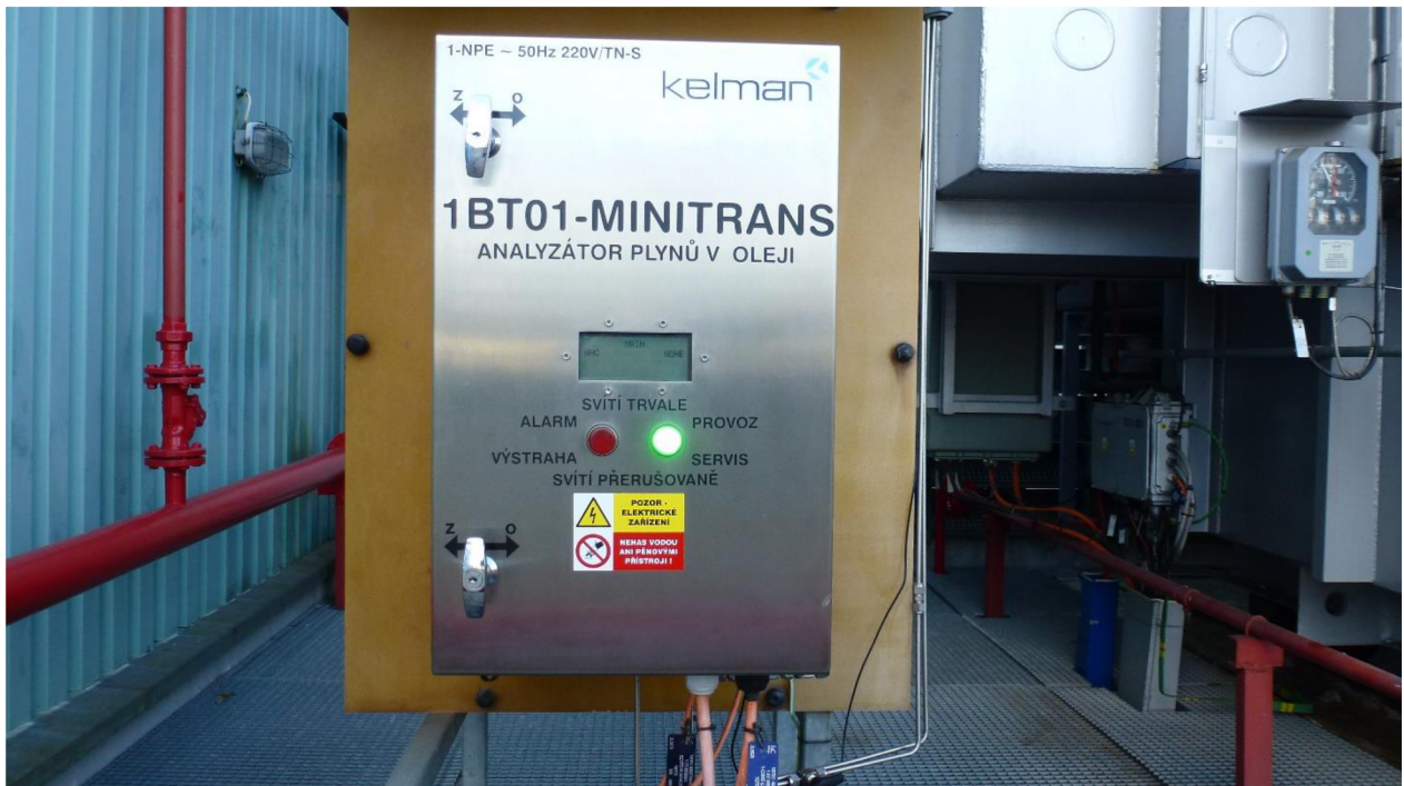
Obr. 3-6 Skříň analyzátoru plynů MINITRANS [5]
