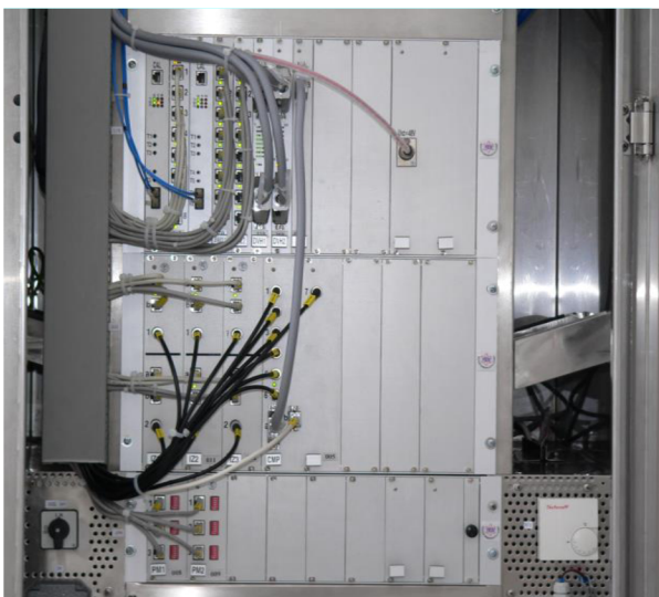
Obr. 4-6 Měřicí skříně MT01 (měřicí ústředna, jednotka úpravy signálů, nosič proudových modulů) [5]
