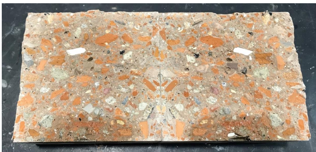
Obrázek 6: Hloubka průsaku tlakovou vodou u betonu CC
