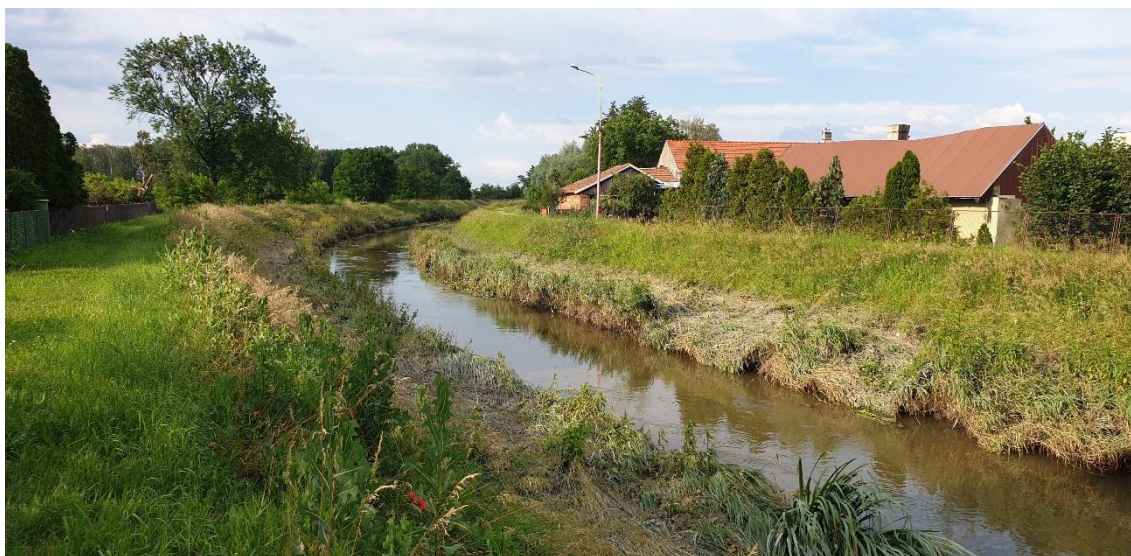
Obrázek 4 - Řeka Mrlina (opadnutí z 2. povodňového stupně v červnu 2020)
