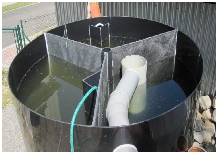
Obr. 3 Standardní tří komorový septik – uspořádání č. 1
