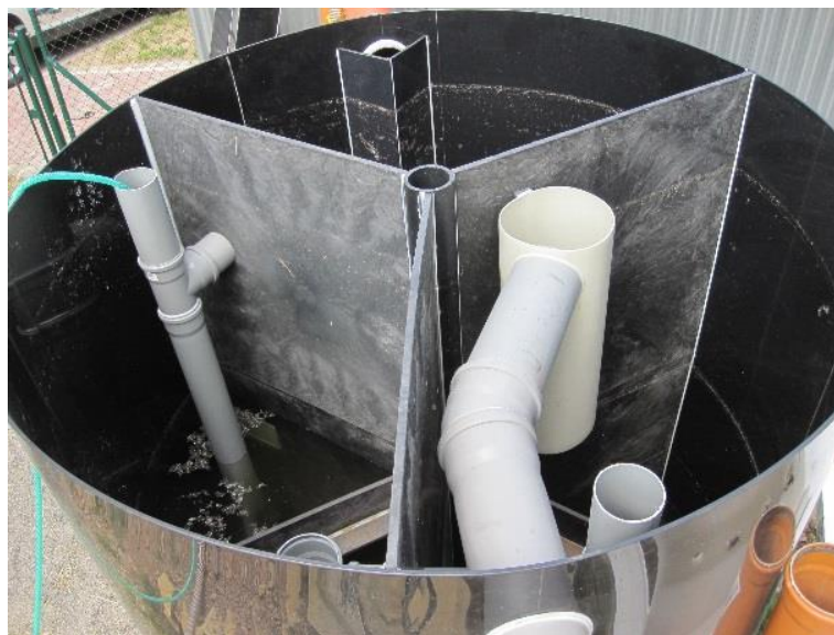
Obr. 11 Uspořádání č. 2 – propojení komor
