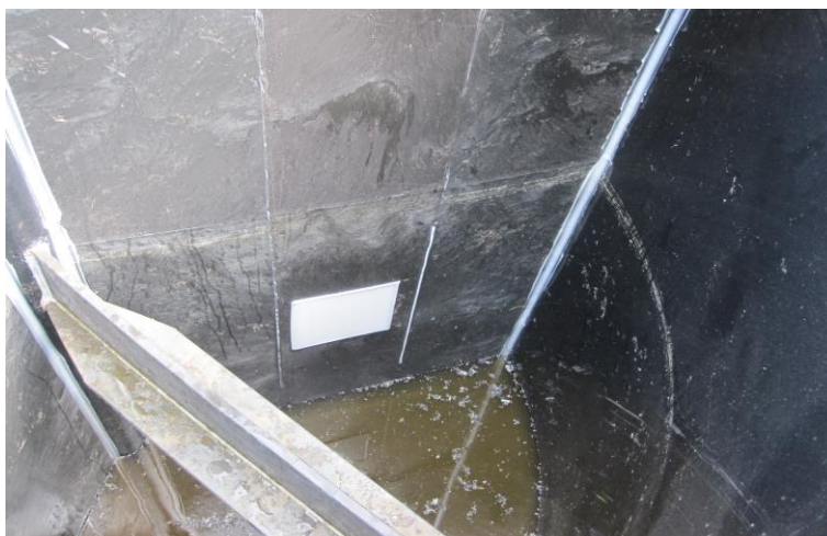
Obr. 8 Odstranění rozražeče a zaslepení otvoru ve druhé komoře
