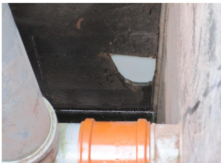
Obr. 23 Zaslepení otvoru u dna třetí komory
