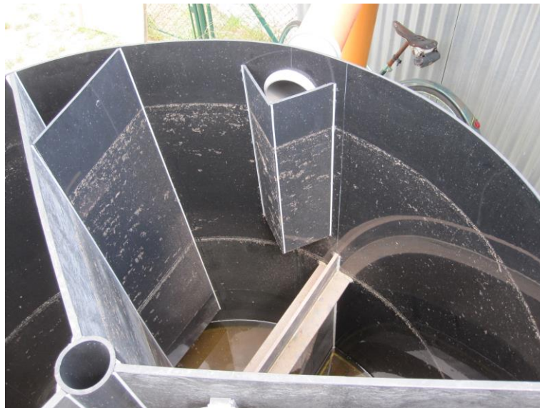
Obr. 4 Norná stěna u přítokového potrubí a před čtvercovým otvorem v dělicí stěně septiku
