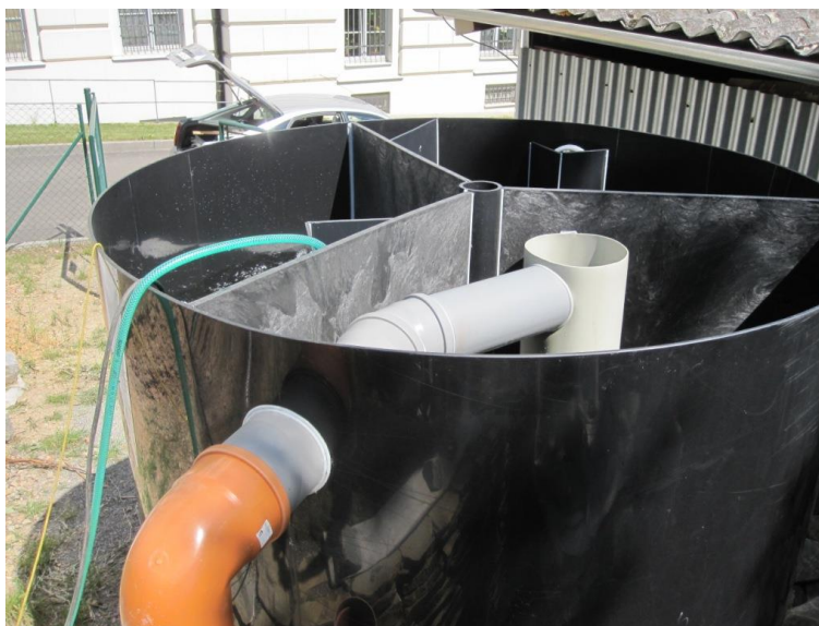
Obr. 31 Napouštění standardního septiku vodou z vodovodu
