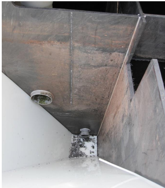
Obr. 24 Instalace kolmého jehlanu na místo norné stěny v první komoře, zaslepení původního potrubí DN 110, propojení potrubím DN 50
