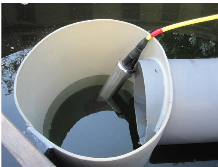
Obr. 41 Umístění měřicí sondy do odtokového potrubí DN 250
