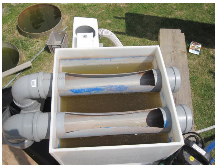
Obr. 18 Přepad přebytečné vody ze šachty
