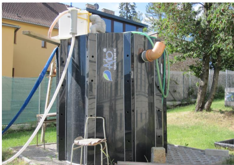
Obr. 28 Regulační přeliv umístěný nad pomocnou nádrží
