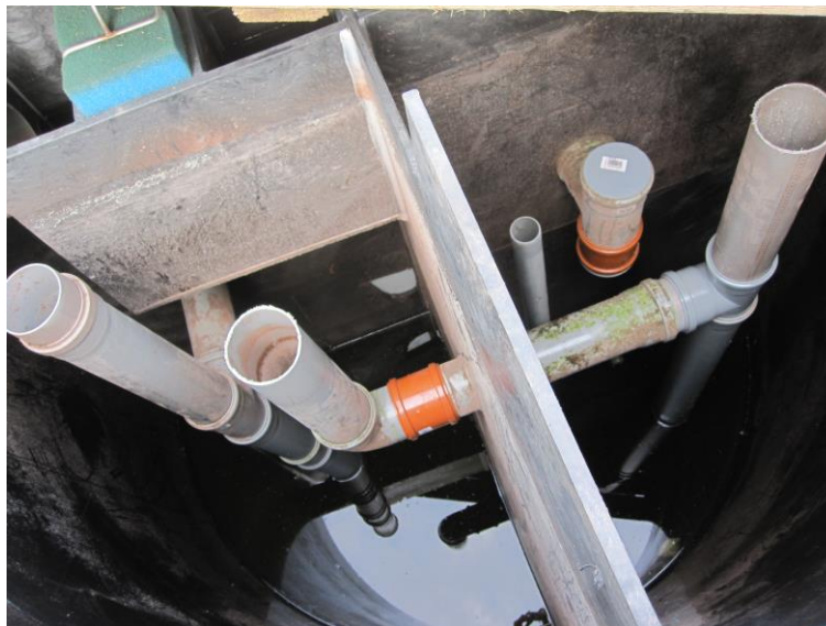
Obr. 25 Pohled na provedení napojení potrubí
