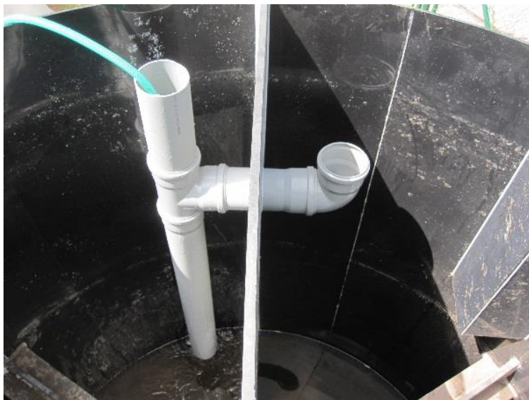
Obr. 9 Detail provedení potrubí DN 110
