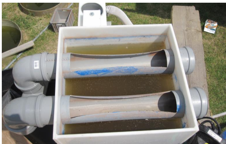
Obr. 27 Pohled na regulační přeliv umístěný nad pomocnou nádrží
