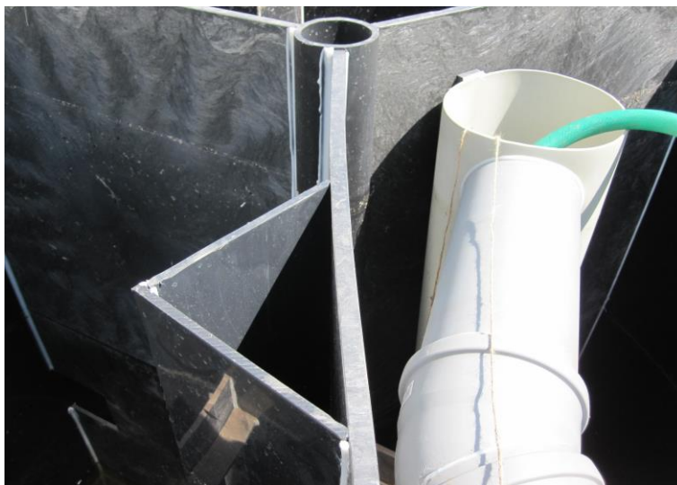
Obr. 37 Detail norné stěny na přechodu z druhé do třetí komory septiku
