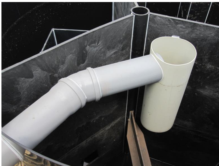
Obr. 6 Provedení odtokového potrubí DN 150
