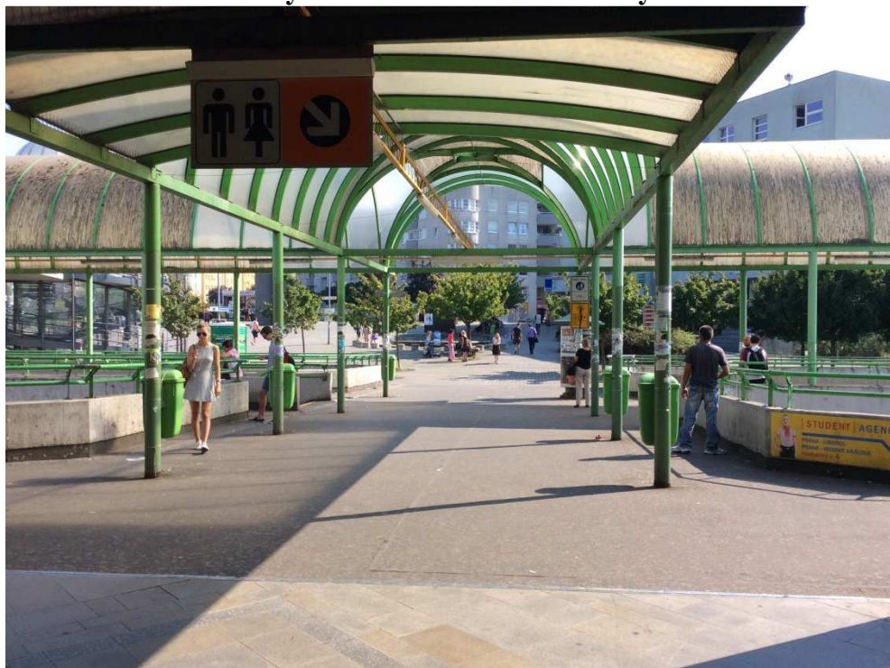
Obrázek 9 Pohled od východu z metra stanice Černý Most
