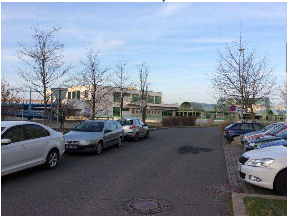
Obrázek 8 Pohled na stavbu metra Černý Most z ulice Bobkova
