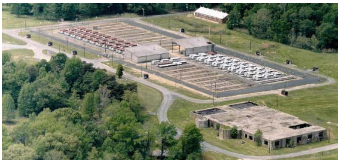
21. a 22. Vojensko-technické chemické zařízení výzkumu Edgewood Arsenal.
