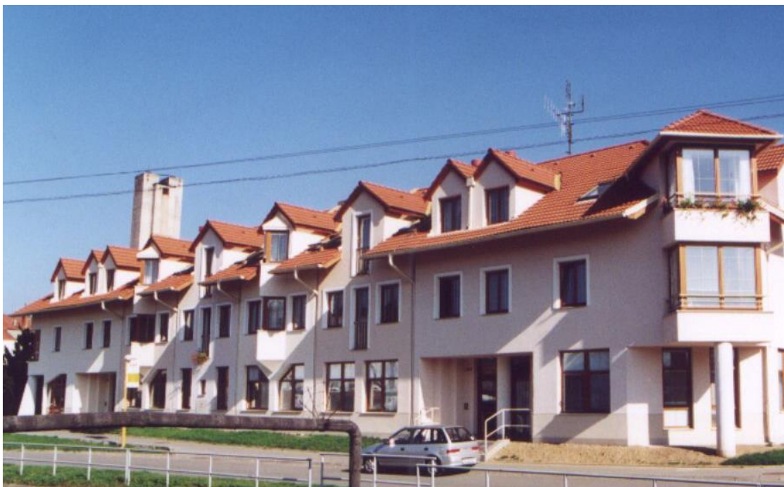
Příloha č. 1 - Budova zařízení Dotek, o.p.s., zdroj:
