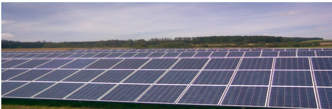
Obrázek 4 Solární elektrárna Pv-park po dokončení
