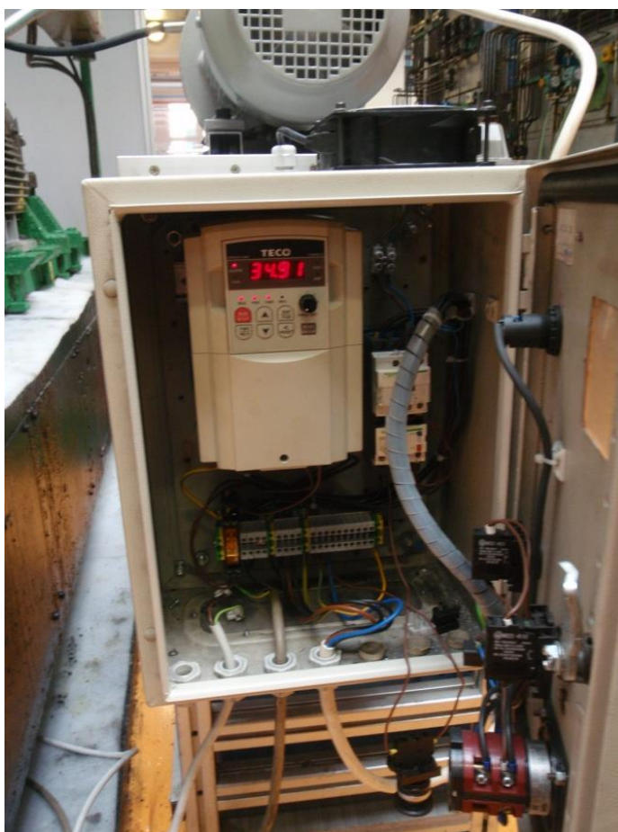
Obrázek 36 – Nastavování jednotlivých frekvencí při měření hmotnostního průtoku čerpadla
