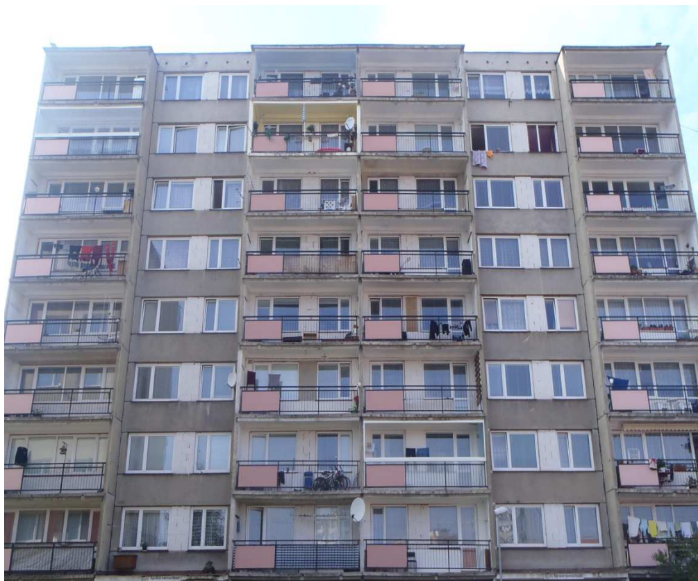
Obrázek 7.1 – Panelový dům před revitalizací
