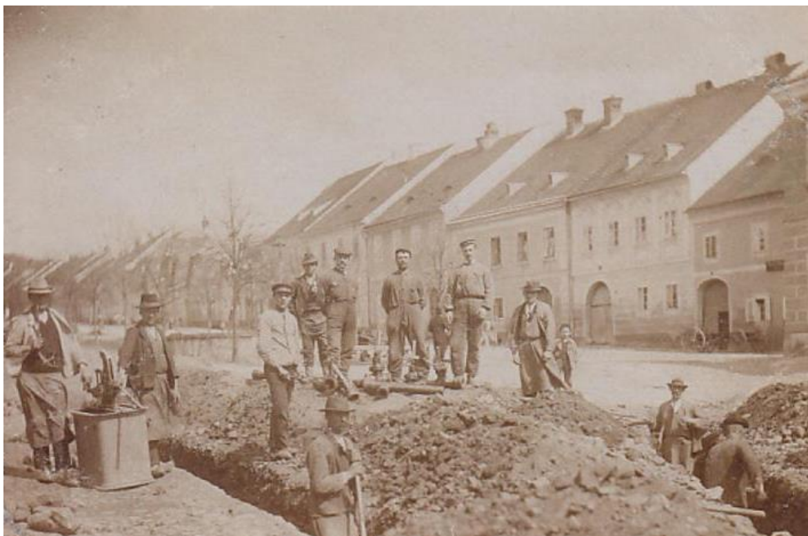
Obr. 2. Fotografie z prostoru „Dolního“ náměstí ve Chvalšínách pořizená roku 1908. Při tomto hloubení výkopů pro inženýrské sítě došlo k nálezům pravděpodobně k prvním registrovaným nálezům archeologického materiálu. Za povšimnutí stojí ruční čerpadla, která pravděpodobně sloužili ke snižování hladiny spodní vody. Zdroj: www.aukro.cz/chvalsiny-krumlov-sumava-dle-raz-vykopy-cca-1908-6929525213
