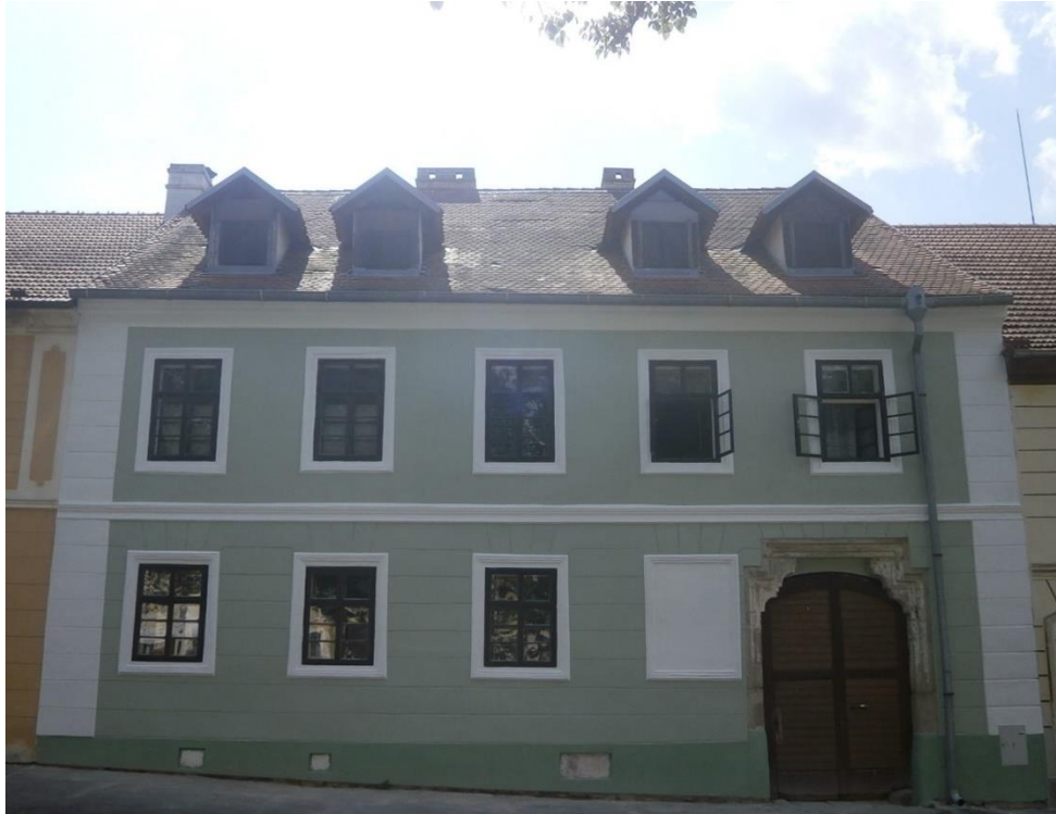
Obr. 6. Chvalšiny č. p. 48. Dům zkoumaný v letech 2010 – 2011 společností Archaia JIH. Foto: Jiří Müller.
