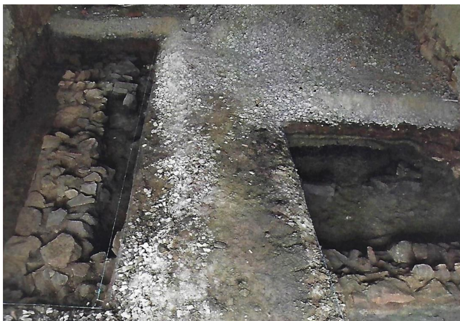
Obr. 43. Chvalšiny č. p. 48. Základové pasy srubové stavby ze 13. století. Zdroj: (Valkony, J. 2011, 14).
