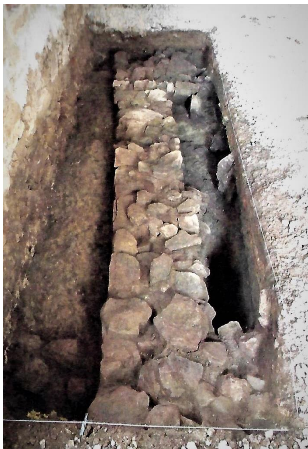
Obr. 42. Chvalšiny č. p. 48. Základové pasy srubové stavby ze 13. století. Zdroj: (Valkony, J. 2011, 12).
