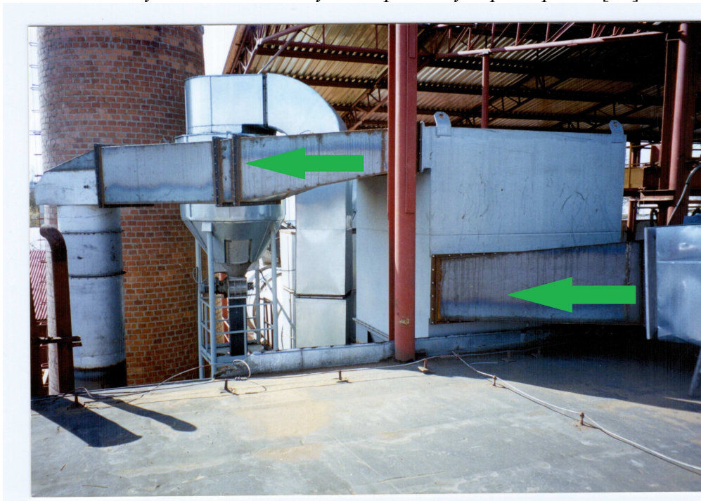
Obr. 8.3 Multicyklon se znázorněným vstupem a výstupem spalin. [24]
