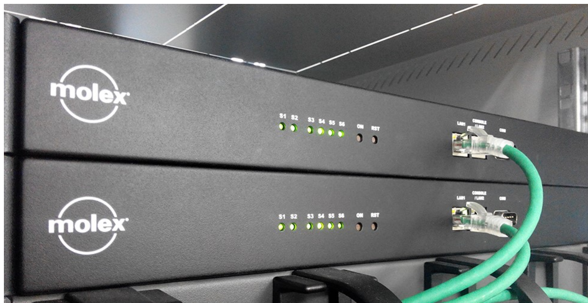
Obrázek 10 - dva MIIM scannerů obsluhující jednu technologickou místnost – status LED (zdroj: autor)
