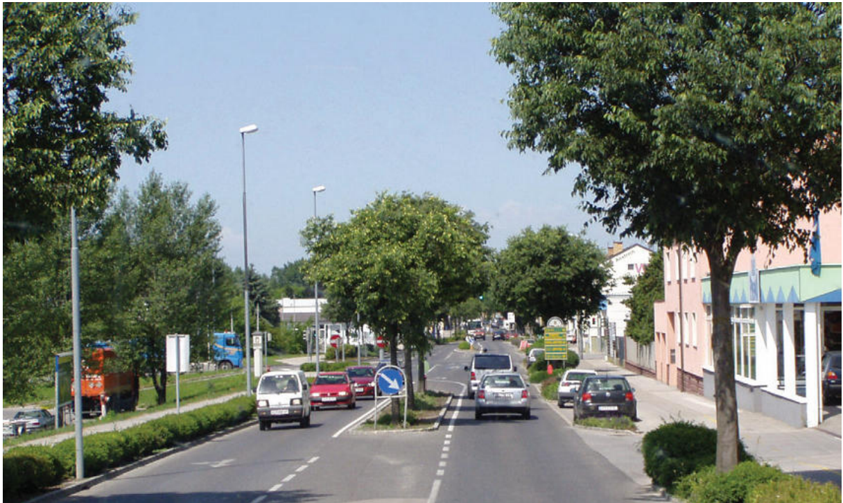
Obr. 1-6 Rekonstrukce průtahu (Těšetice, ČR) [22]
