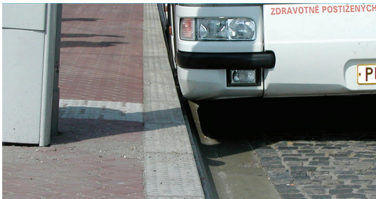
Obr. 1-17 Profilový obrubník pro těsný nájezd vozidla (Pardubice, ČR) [21]
