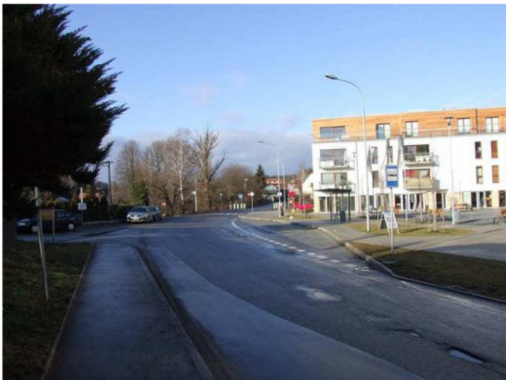
Prostor u autobusové zastávky Statenice, U Kovárny (foceno ve směru na Tuchoměřice)
