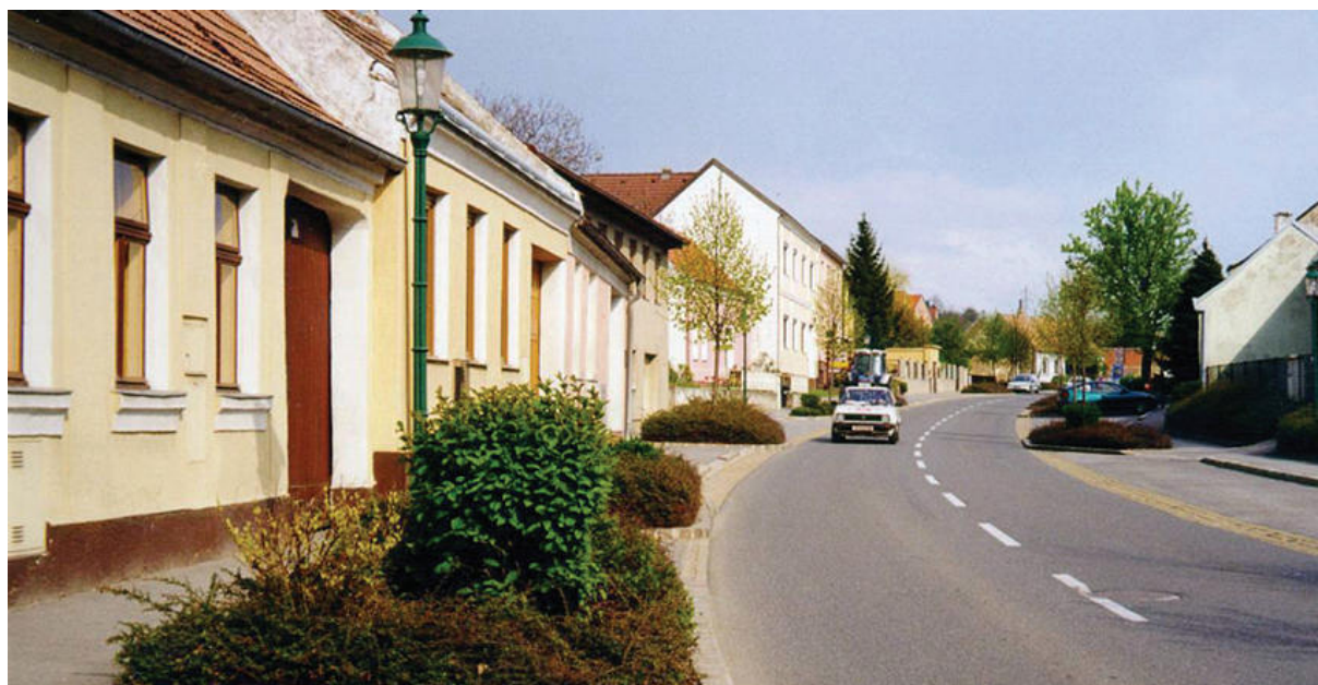
Obr. 1-5 Rekonstruovaný průtah (Mürzzuschlag, Rakousko) [21]
