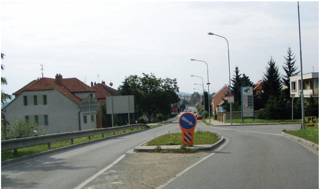
Obr. 1-7 Rekonstruovaný průtah (Rajhrad, ČR) [22]
