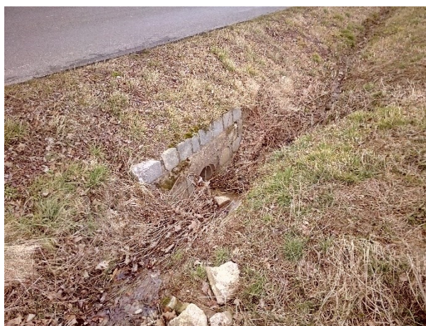
Obr. 52 Záchytný příkop a propustek KP 12 (Poruba, foto M. Majkus, II. 2020)
