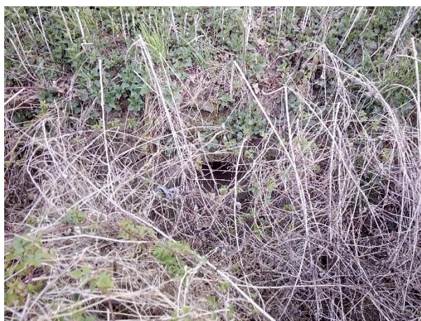
Obr. 34 Vtok do propustku v KP 5 (Hustopeče n./B., foto M. Majkus, IV. 2020)
