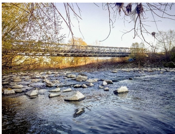
Obr. 11 Silniční most přes Bečvu (Hustopeče n./B., foto M. Majkus, IV. 2020)
