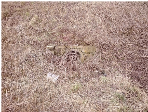
Obr. 49 Vtok do propustku v KP 11 (Poruba, foto M. Majkus, II. 2020)
