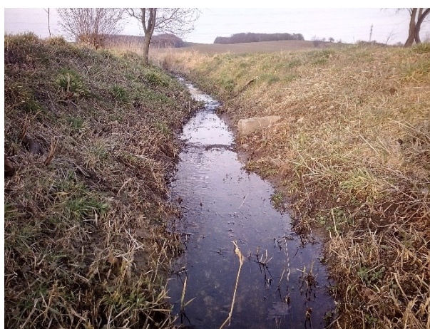
Obr. 23 Svodný příkop v pravé části svahu (Hustopeče n./B., foto M. Majkus, II. 2020)
