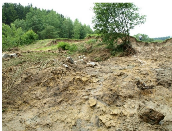
Obr. 7 Hráz retenční nádrže poškozená při povodni (Hustopeče n/B., foto V. Vahala, VI. 2009) [12]
