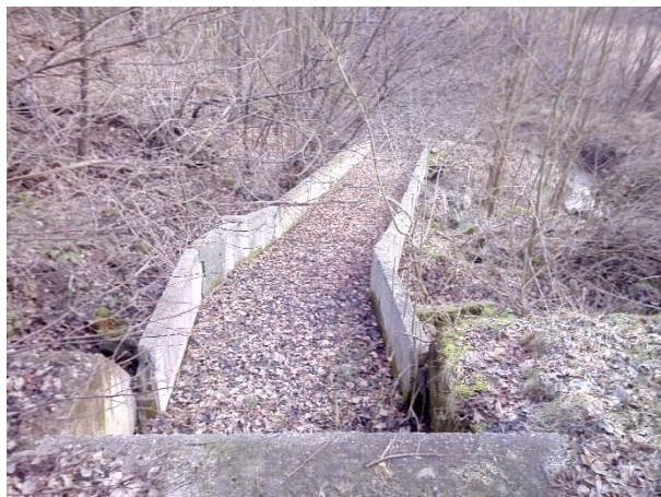
Obr. 64 Boční bezpečnostní přeliv (Hustopeče n./B., foto M. Majkus, II. 2020)
