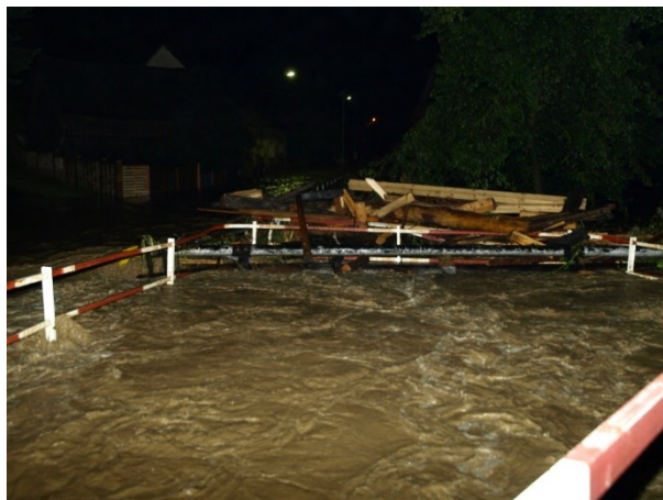
Obr. 5 Loučský potok při povodni cca 1,5 m pod max. úrovní (Hustopeče n/B., foto V. Vahala, VI. 2009) [12]
