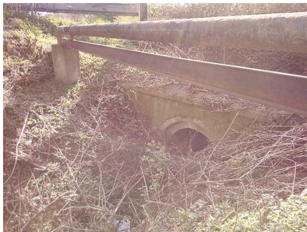
Obr. 68 Vtok do propustku v KP 18 (Poruba, foto M. Majkus, IV. 2020)
