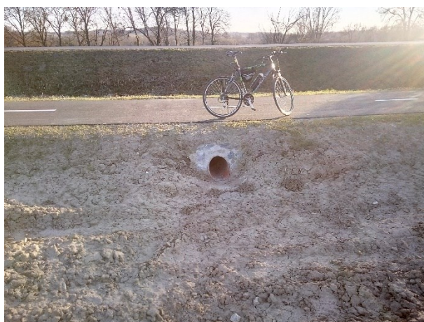
Obr. 40 Propustek pod cyklostezkou v KP 7 (Hustopeče n./B., foto M. Majkus, III. 2020)
