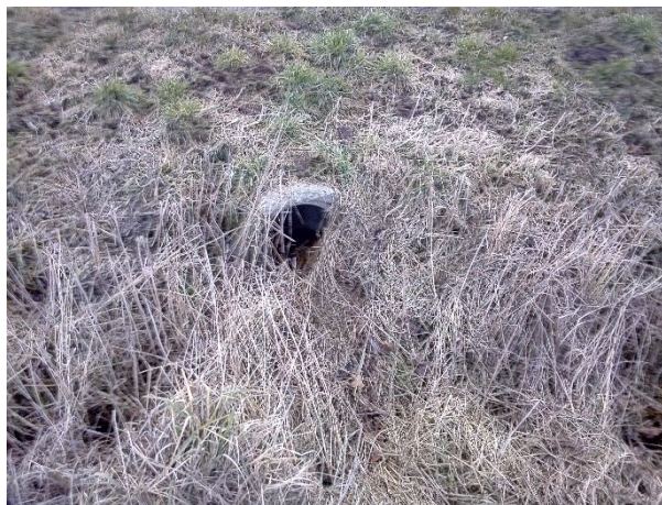
Obr. 31 Propustek pod komunikací v KP 4 (Hustopeče n./B., foto M. Majkus, II. 2020)
