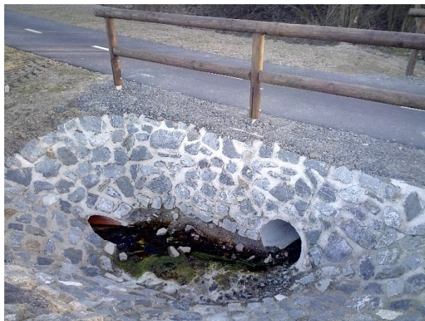
Obr. 38 Propustek pod cyklostezkou v KP 6 (Hustopeče n./B., foto M. Majkus, III. 2020)
