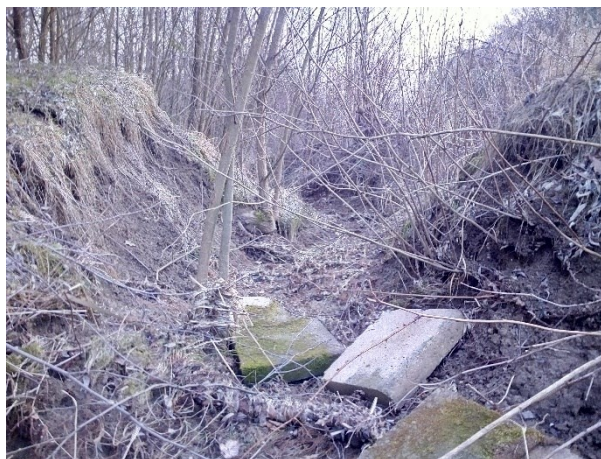
Obr. 63 Protržená hráz retenční nádrže (Hustopeče n./B., foto M. Majkus, II. 2020)
