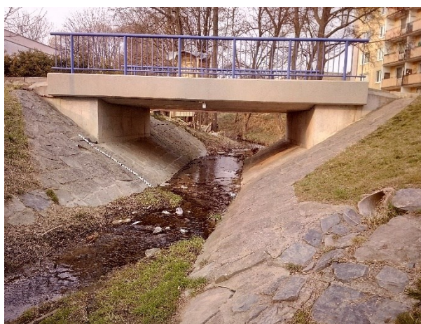
Obr. 58 Pohled na mostní konstrukci a okolí KB 5 (Hustopeče n./B., foto M. Majkus, III. 2020)
